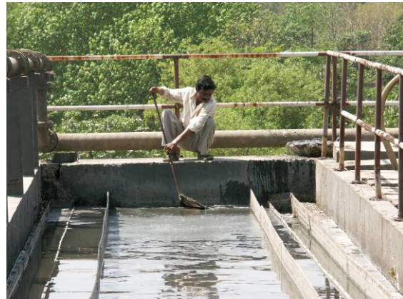
Nettoyage du dessus du réacteur UASB Station d'épuration UASB 36 000 m 3 /j Jajmau, Kanpur, 21 mars 2008
