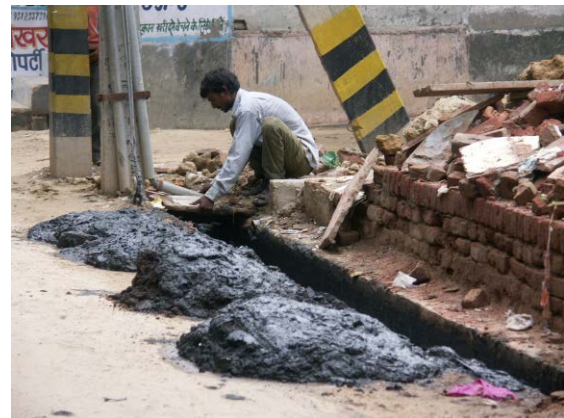
Nettoyage d'une rigole d'assainissement Raja Puri, Delhi, 4 juillet 2007
