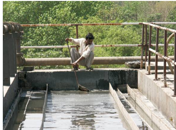
Nettoyage du dessus du réacteur UASB Station d'épuration UASB 36 000 m 3 /j Jajmau, Kanpur, 21 mars 2008
