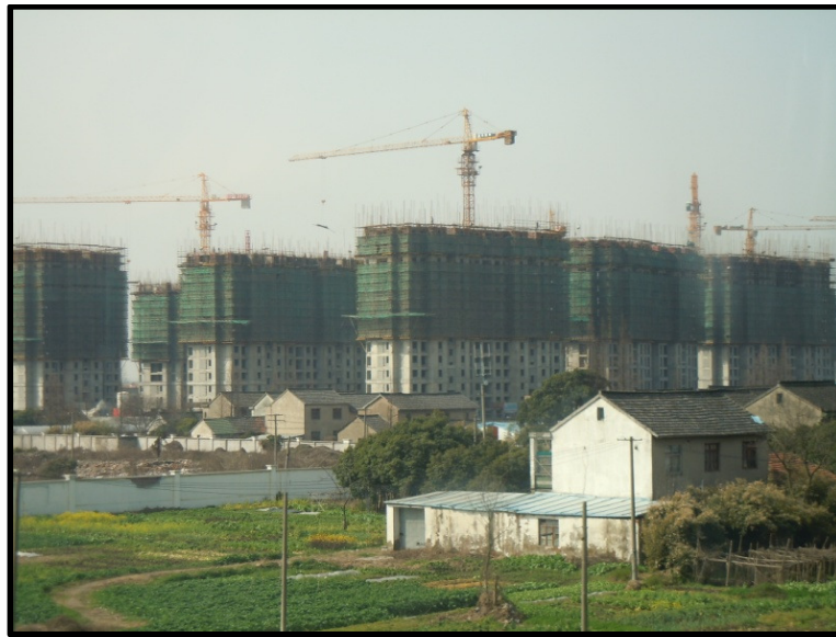
Photographie 8 : La fragmentation spatiale entre la ville nouvelle de Songjiang en construction et les villages alentour
