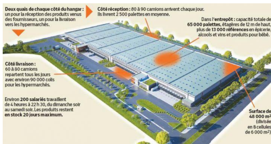
Figure 2-1 : un entrepôt de la grande distribution (Auchan à Trappes, 78)
