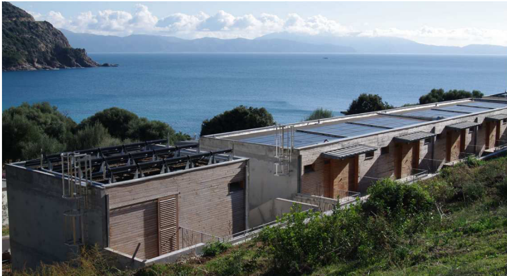
FIGURE 3.1 – Bâtiment résidentiel « Charpak », Cargèse
