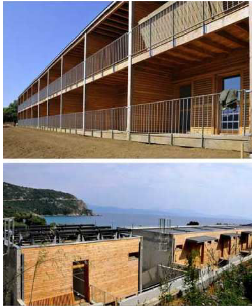
FIGURE 1.4 – Bâtiment d'hébergement « Charpak », Cargèse
