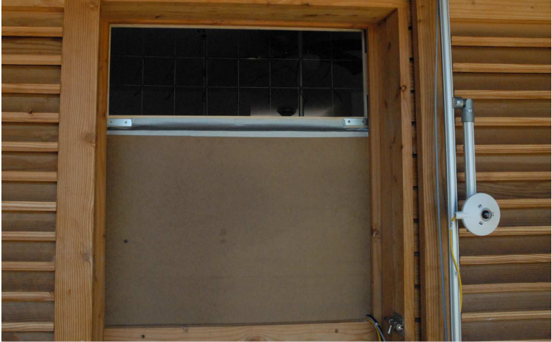
FIGURE 3.21 – Fenêtre réduite et cadre, vue de l'extérieur
