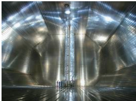
Intérieur d'une cuve de méthanier
