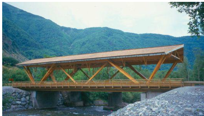
Pont Routier des Fayettees à Valbonnais (38)
