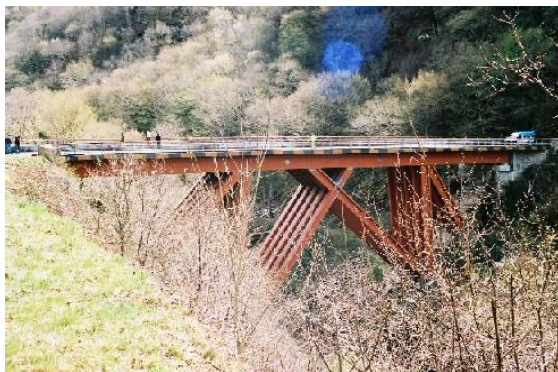
Pont Routier de Merle (19)
