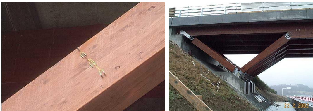
Sondes hydriques mises en place in situ (Passage Supérieur du Chavanon)
