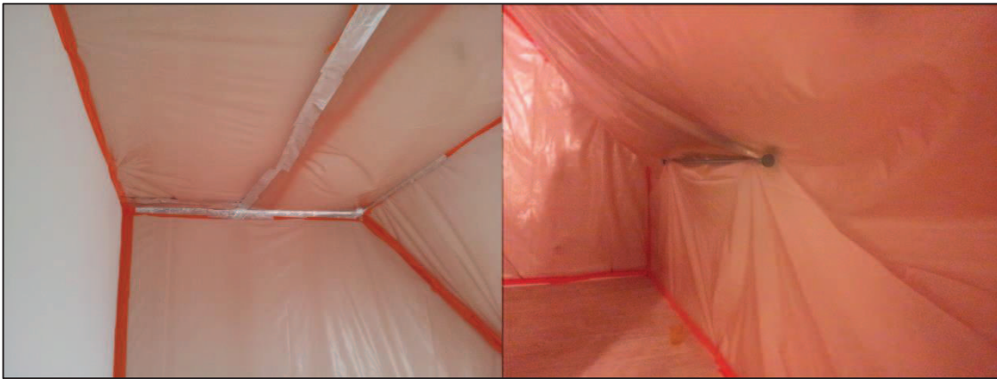
Figure III.31 - Bâche de polyane pour étanchifier les murs
