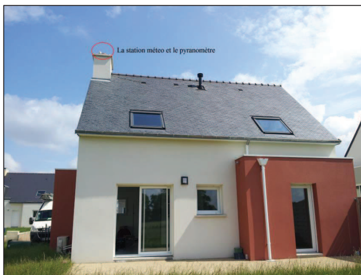
Figure III.14 – L'emplacement de la station météo et du pyranomètre
