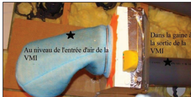
Figure III.25 – L'emplacement des Grimm 1.108 dans les combles
