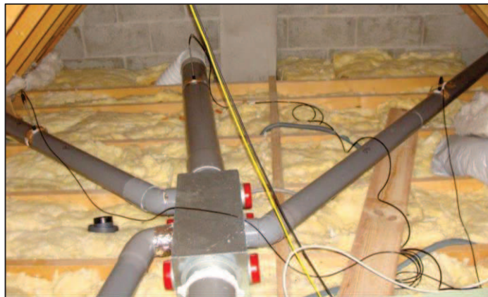
Figure III.8 – VMI-R : réseau de distribution de l'air
