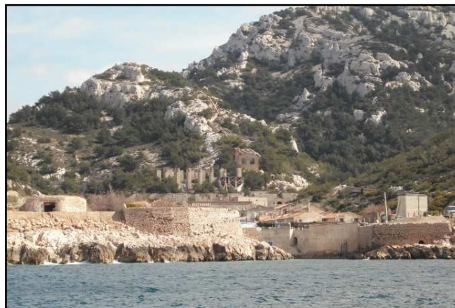
Figure II.4: Photographie de l'ancien site industriel de l'Escalette et de l'entrée du port.
