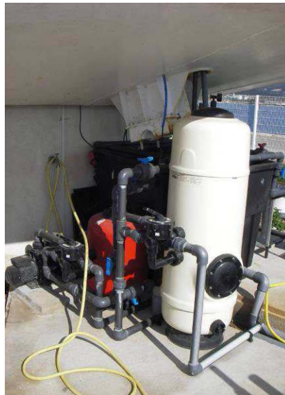
Figure 15 : Circuit principal d'eau et systèmes de filtration
