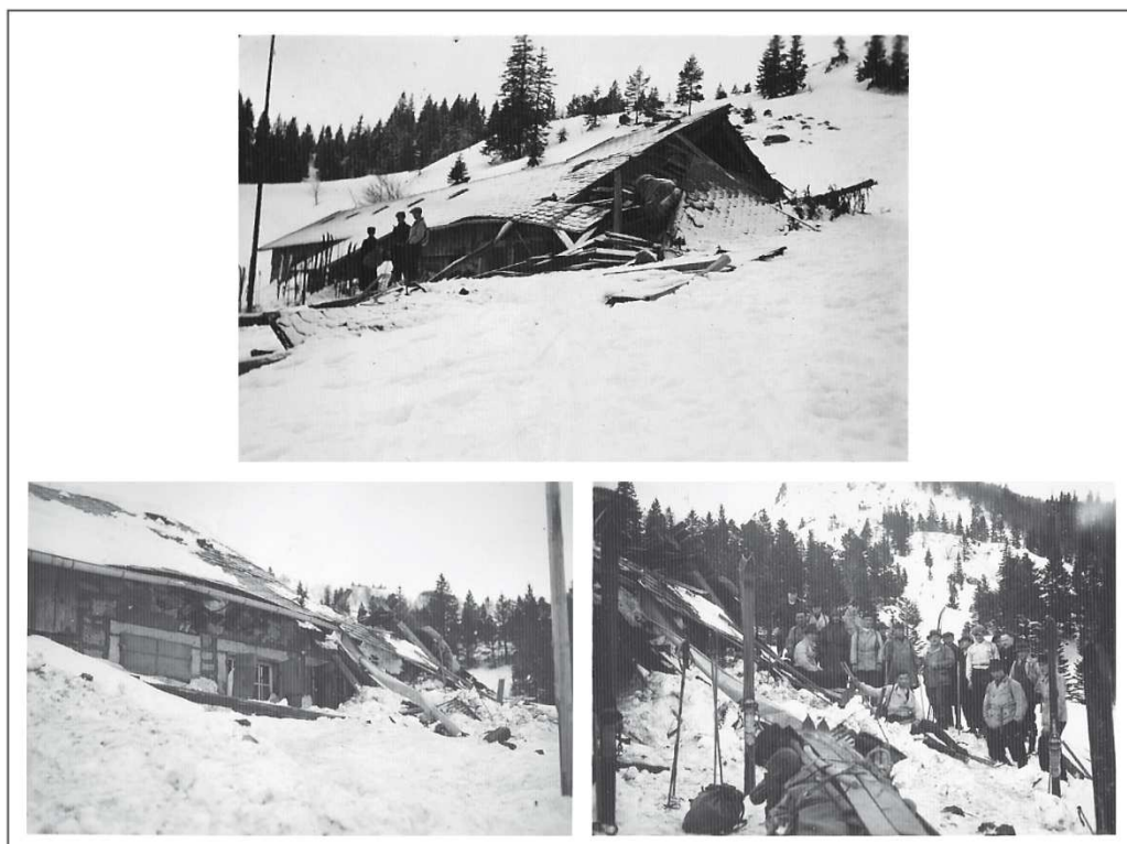
Figure 42 : Photographies de la ferme du Seestaettlé (Tanet) endommagée par une avalanche le 19 janvier 1941. Collection privée : H. Edenwald.
