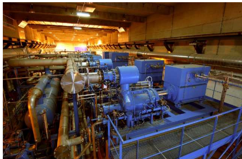
FIGURE 6.10 – Station de compression du CERN pour le LHC [2]
