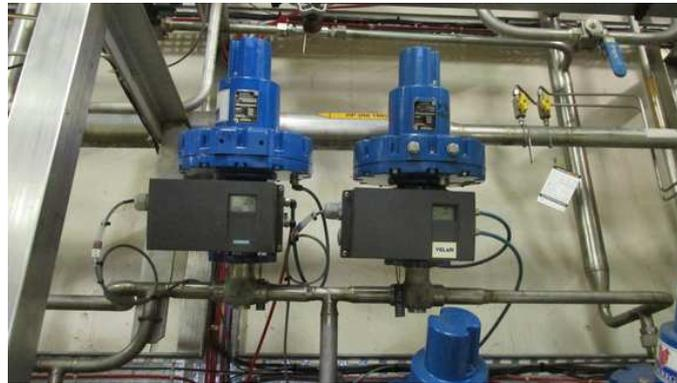
FIGURE 2.8 – Vannes d'apport et de retrait de gaz de la station de compression du SBT avec leur positionneur et actionneur pneumatique
