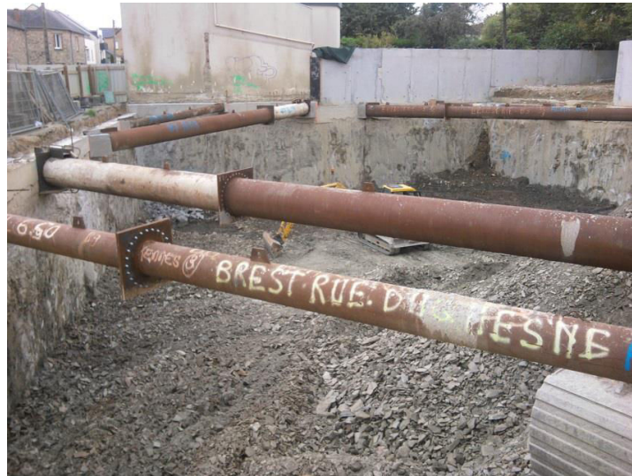
Figure 3.4 Paroi moulée butonnée en tête (source : Dacquín)
