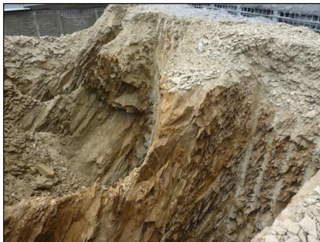
Figure 3.1 Excavation à la pelle mécanique sur un chantier de soutènement (source : Dacquin)
