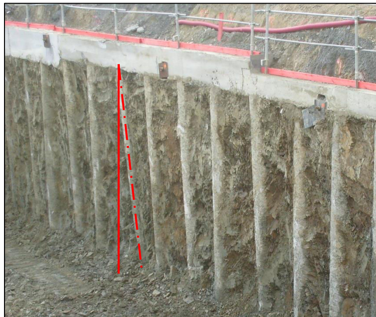
Figure 2.2. Déviation perpendiculairement à la paroi et orienté vers l'extérieur de la fouille (source : Groupe Dacquin). Chantier Siège Archipel Habitat, 2011 (sud de Rennes)
