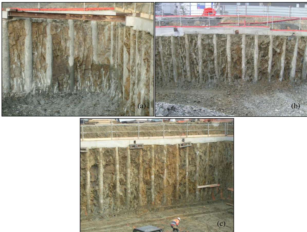
Figure 1.1 Différents degrés d'altération au sein d'une même fouille : (a) schistes rocheux peu altérés, (b) schistes moyennement altérés, (c) schistes fortement altérés
