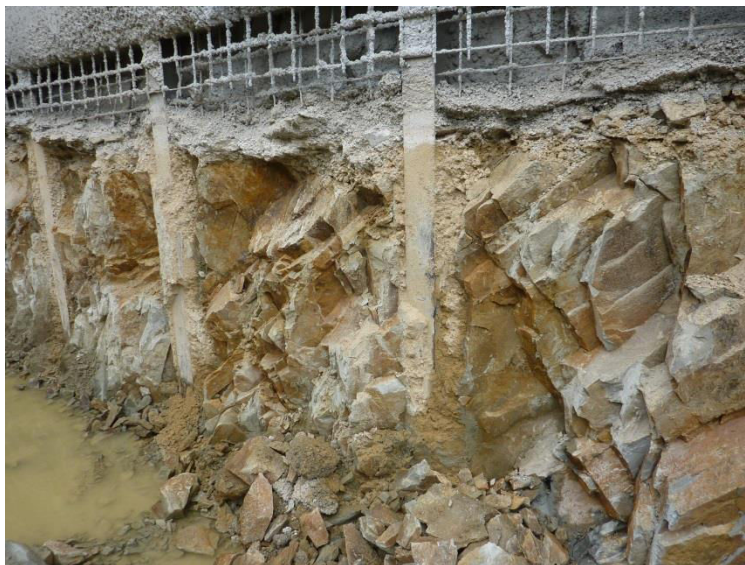
Figure 3.2 Photographie d'une paroi berlinoise avec un parement en béton projeté réalisé dans les schistes briovériens (source : Groupe Dacquín)
