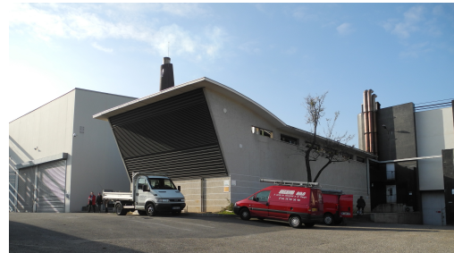
(b) Chaufferie alimentant le réseau de chaleur de la commune de Vénissieux – Antoine Tabourdeau, 2012
