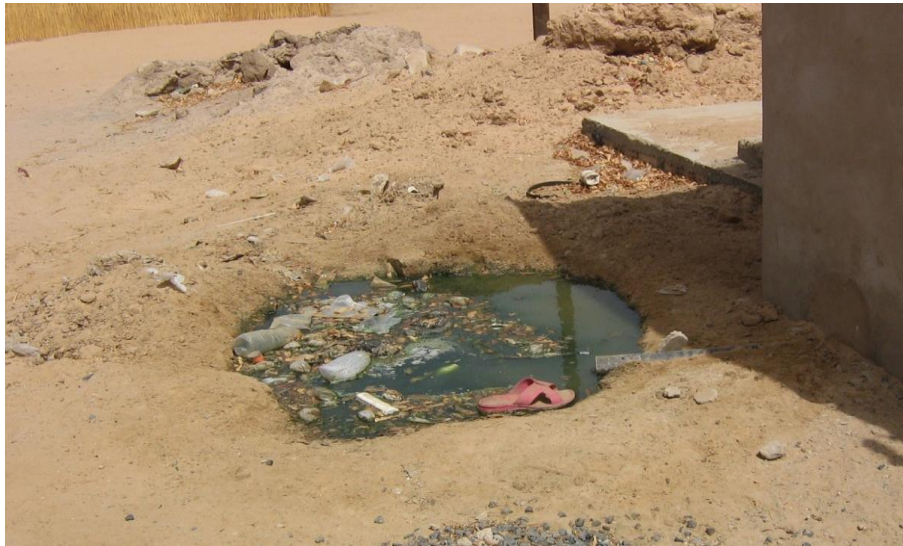
Cliché 4: Type de drainage courant des eaux usées (N dame, CR Touba Mosquée)
