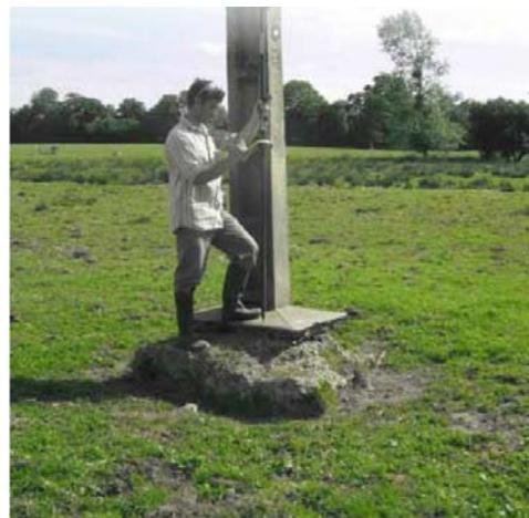
**Figure 31. Affaissement de sol marqué par l'écart entre le sol et la base du poteau électrique (source : <http://www.cc-carentan-cotentin.fr>).**
