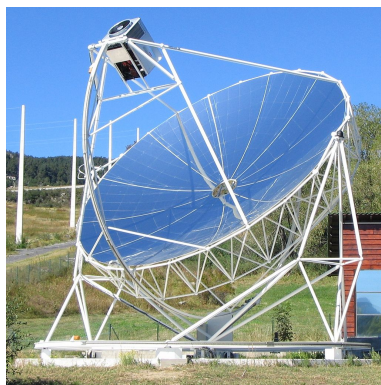
(c) Concentrateurs paraboliques : Projet DISH-STIRLING à Odeillo [4]
