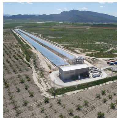
(d) Capteurs linéaires de Fresnel : Centrale Novatec Biosol
