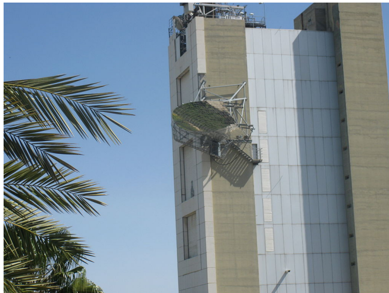
FIG. 1.4. : Réflecteur secondaire de type « beam down » au Weizmann Institute of Science [4]
