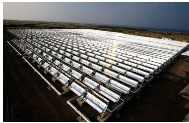
(a) Capteurs cylindro-paraboliques : Centrale solaire de Kaehole à Hawaï [4]
