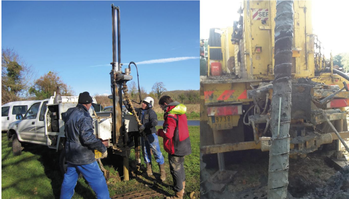
Figure 2. Forages à la tarière dans le bassin versant de la Dives (Campagne BRGM 2013, photographie : Tissoux, à gauche, la tarière avec un diamètre de 10 cm et à droite, la tarière avec un diamètre 15-20 cm. Profondeur maximum atteinte pour les nappes alluviales : 22 m)
