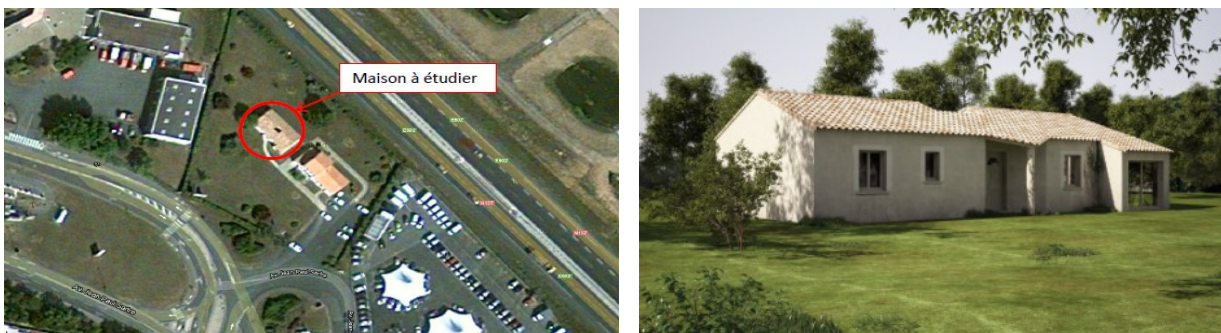
Figure 53 – Vue aérienne et photographie de la maison individuelle servant d'étude de cas
