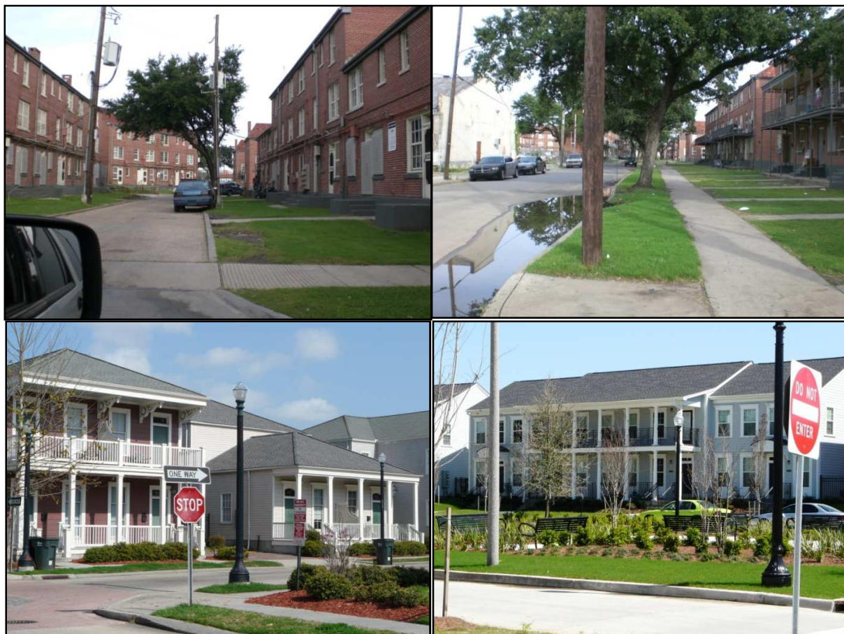
Figure 254 : Une transformation des grands ensembles de logements sociaux après Katrina favorisant la sécurité (en haut Iberville en grande partie condamné mais non reconstruit, en bas, les anciens logements sociaux reconvertis en « quartiers à mixité sociale et fonctionnelle », River Garden à gauche, Harmony Oaks à droite). (Clichés de l'auteur, 2010 et 2011).
