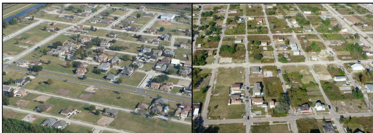
Figure 201 : Une dédensification caractérisée par une alternance de parcelles vides et de logements occupés et vacants, qui favorise les cambriolages (parcelles et logements vacants entretenus dans le quartier de Read Blvd East à gauche et non entretenus dans le quartier du Lower 9th Ward à droite). (Clichés de l'auteur, 2011).
