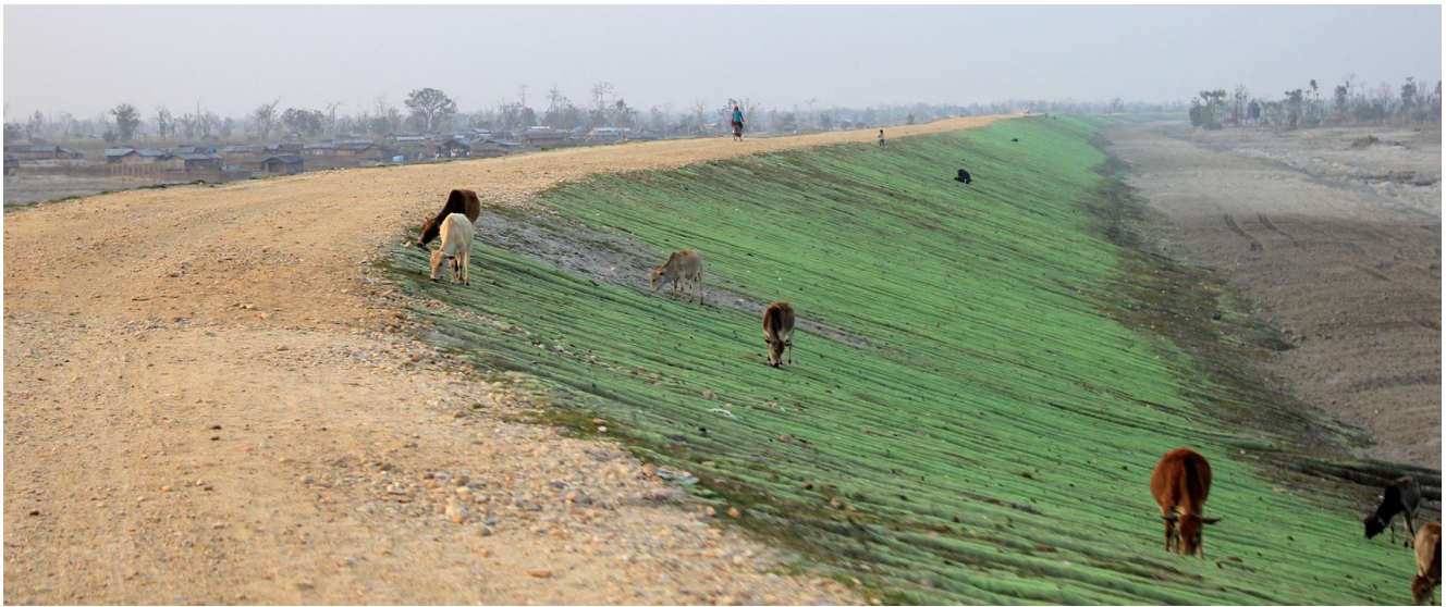
Photo 24 : La digue en géotextile de Matmora en février 2011.
