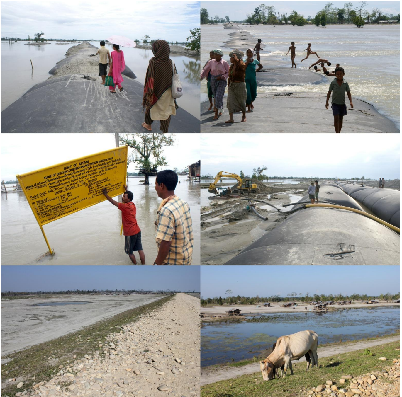
Planche photo 34 : Construction de la digue (Dhakuakhana). 1 et 2 - En 2009, la construction de digue a été interrompue par la crue du 1 er juillet au 30 août ; 3 - Le panneau de présentation des caractéristiques de l'aménagement a été emporté par les flots ; 4- Les travaux ont repris après la décrue ; 5 et 6 - En janvier 2011, la digue construite et le village d'Ekoria Matmora pu se réinstaller en arrière.
