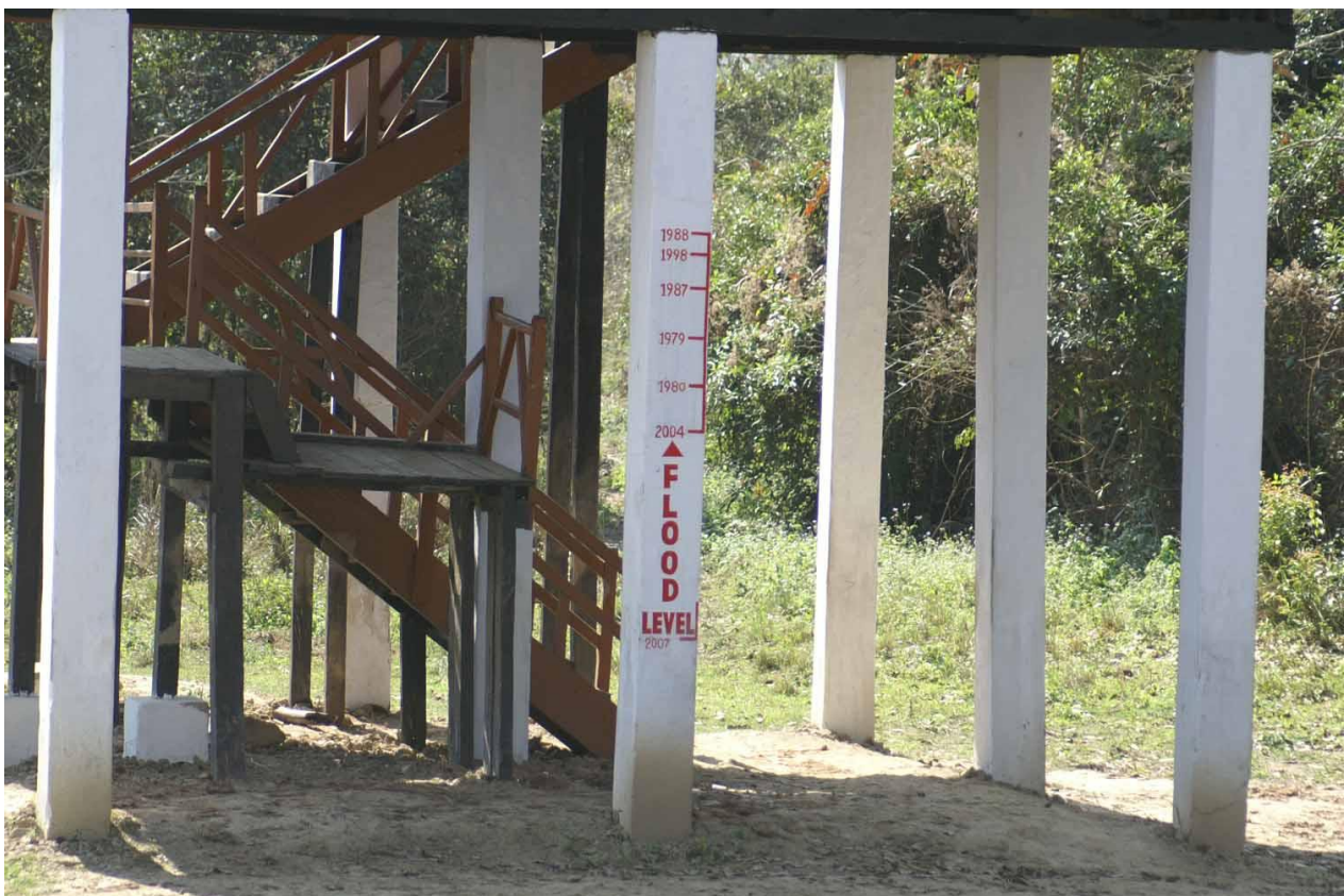
Photo 2 : Les repères marqués sur les pilotis de cette tour d’observation du parc national de Kaziranga indiquent que les crues les plus importantes au cours des 35 dernières années furent celles de 1979, 1980, 1987, 1988, 1998, 2004 et 2007.
