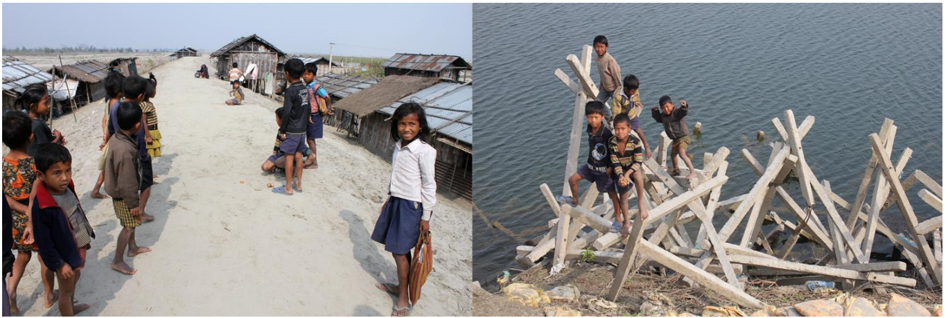
Planche photo 35 : Des enfants du village de Baligaon (Dhakuakhana). 1- Les enfants du village jouent sur la digue. Les maisons s'organisent de part et d'autre de celle-ci. 2- Les enfants jouent sur des éperons et des brise-lames (porcs-épics) construits pour freiner l'érosion.
