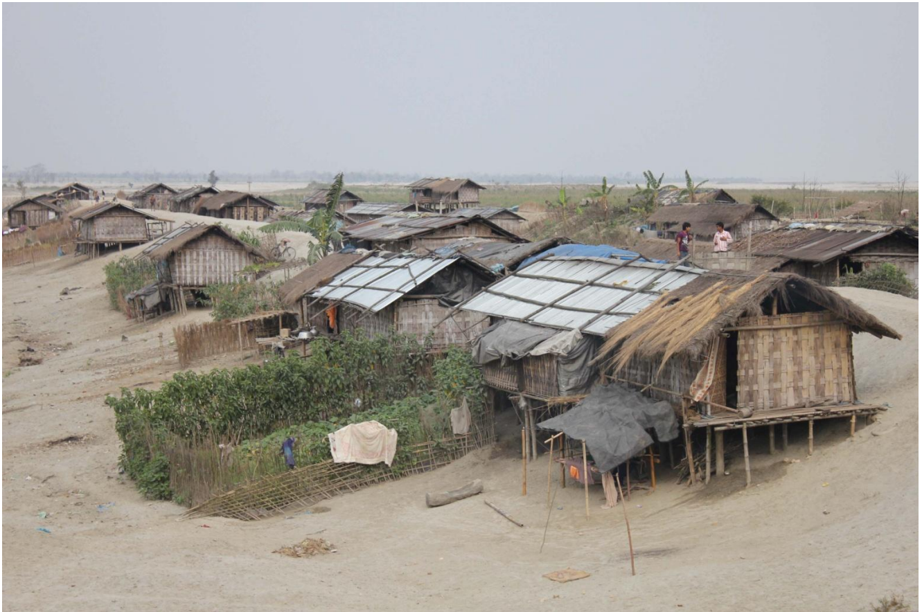
Photo 6 : Village d'Arkep Baligaon. Les terres du village ont été érodées et les habitants ont reconstruit leurs maisons sur pilotis le long d'un débris de digue, janvier 2010.
