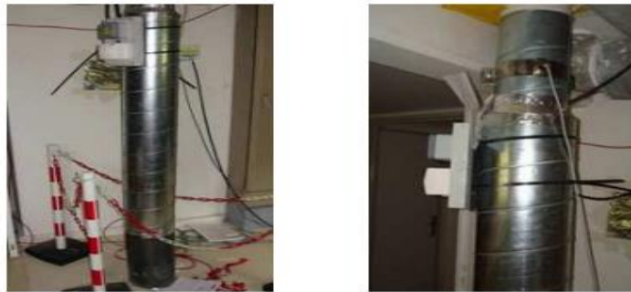
Figure 4.13 : Photos du conduit reliant le puisard à la cheminée
