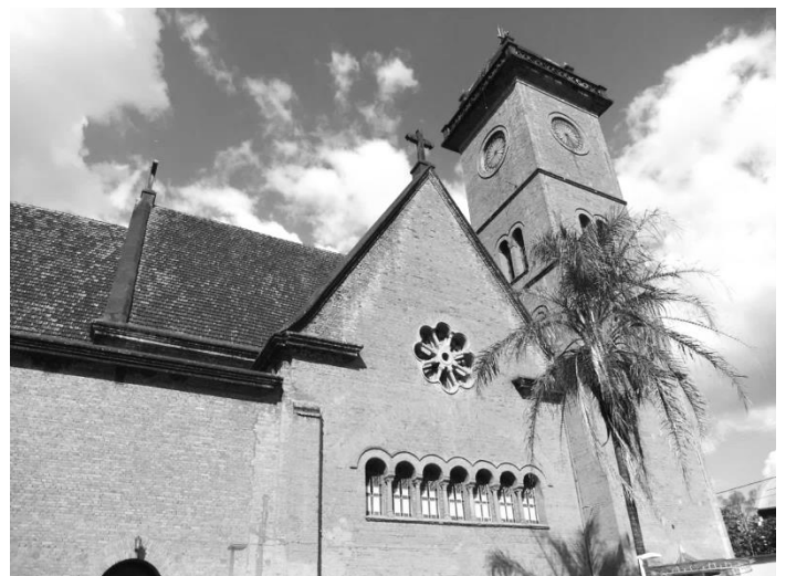
Chapelle du collège des sœurs dominicaines à Uberaba construites par les missionnaires Photographie personnelle de l'auteur, 2010.
