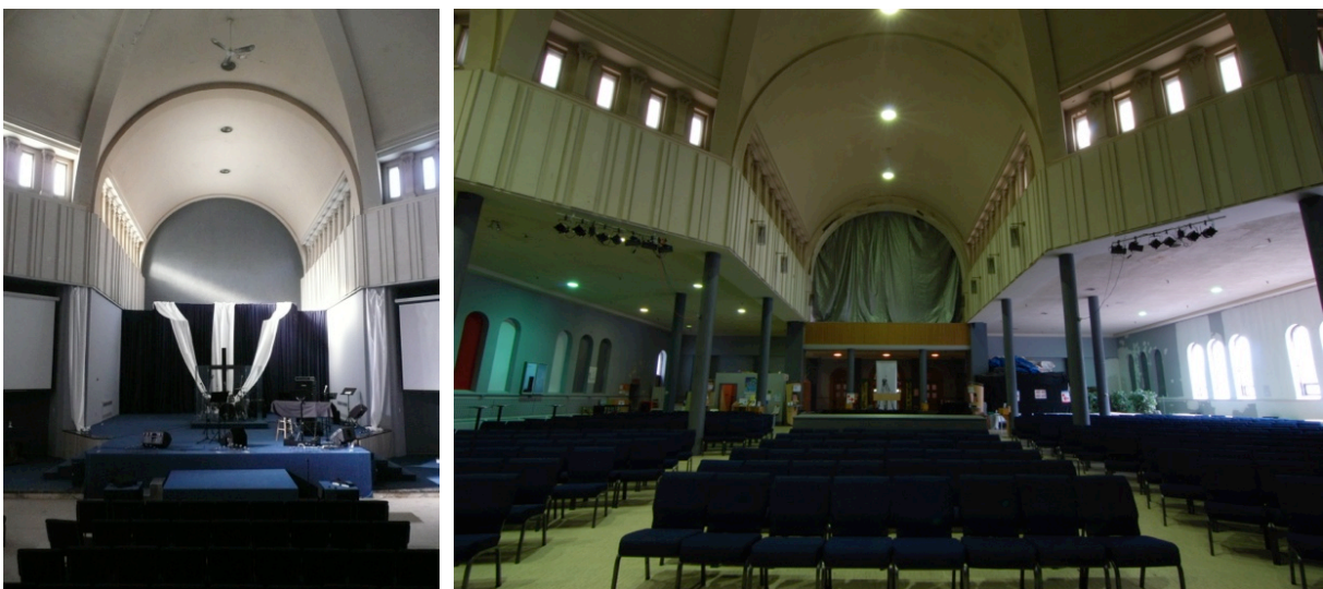
Construction en 1919 d'après les plans de Louis-Napoléon Audet. Photos : Guillaume St-Jean, 2009 et Marianne Charland, 2012.
