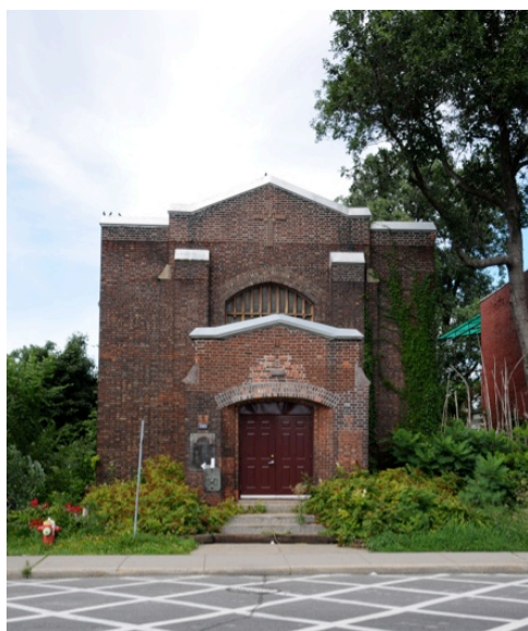
Illustration 3.38. Ancienne église presbytérienne Béthanie, puis des Montréalais, Montréal.
