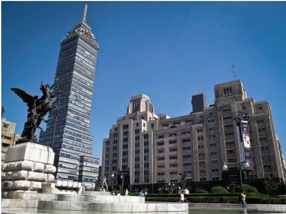
19. Devant le Palais des Beaux Arts, deux anciens gratte-ciels : La Nacional (1933) et la Tour Latino-américaine (1956). À droite, l'immeuble acquis par CHCM SA de CV pour accueillir les magasins Sears.
