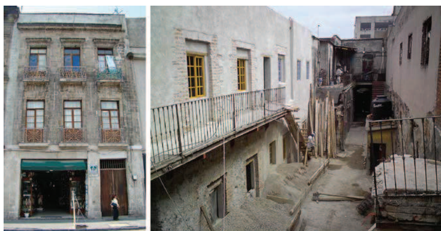
Clichés 18. Des réhabilitations menées par l'INVI
