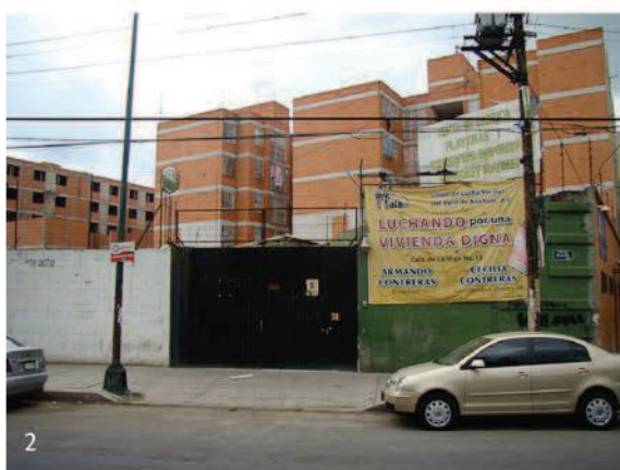
2 La Viga 13, à bâtir. Derrière : l'Esemble Clavijero
