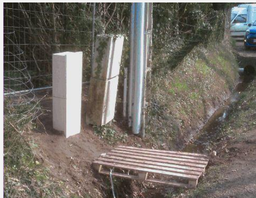
Figure 35 : Photo remontée du coffret en haut de talus (situation d'avant).
