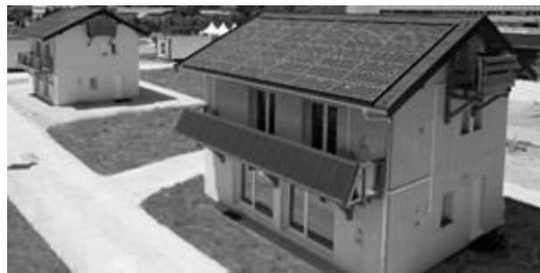
Figure III-11: Maisons INCAS (image : www.ines-solaire.org )
