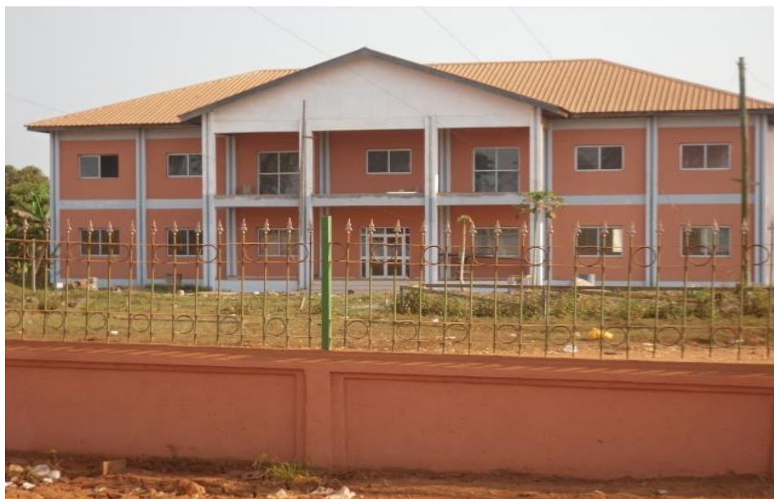
Figure 16 : Immeuble de l'hôtel de ville de Djoum en construction
