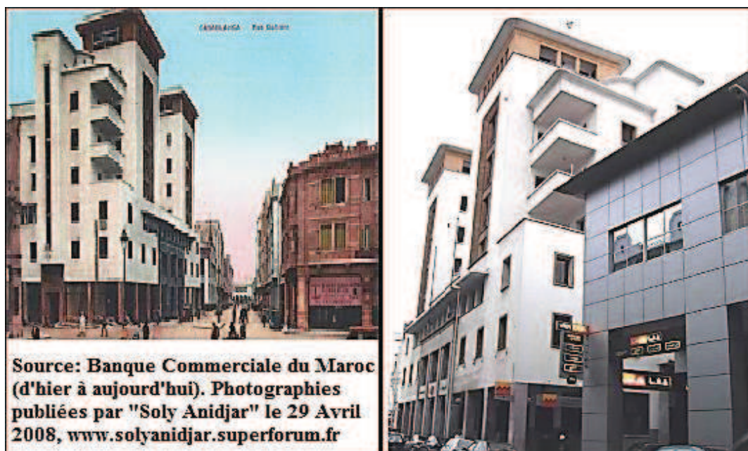
Figure 4.2 : Banque Commerciale du Maroc à Casablanca (Bd. Driss Lahrizi, ex-rue Gallieni).
