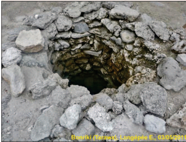
Citerne de stockage de l'eau du réseau d'eau
