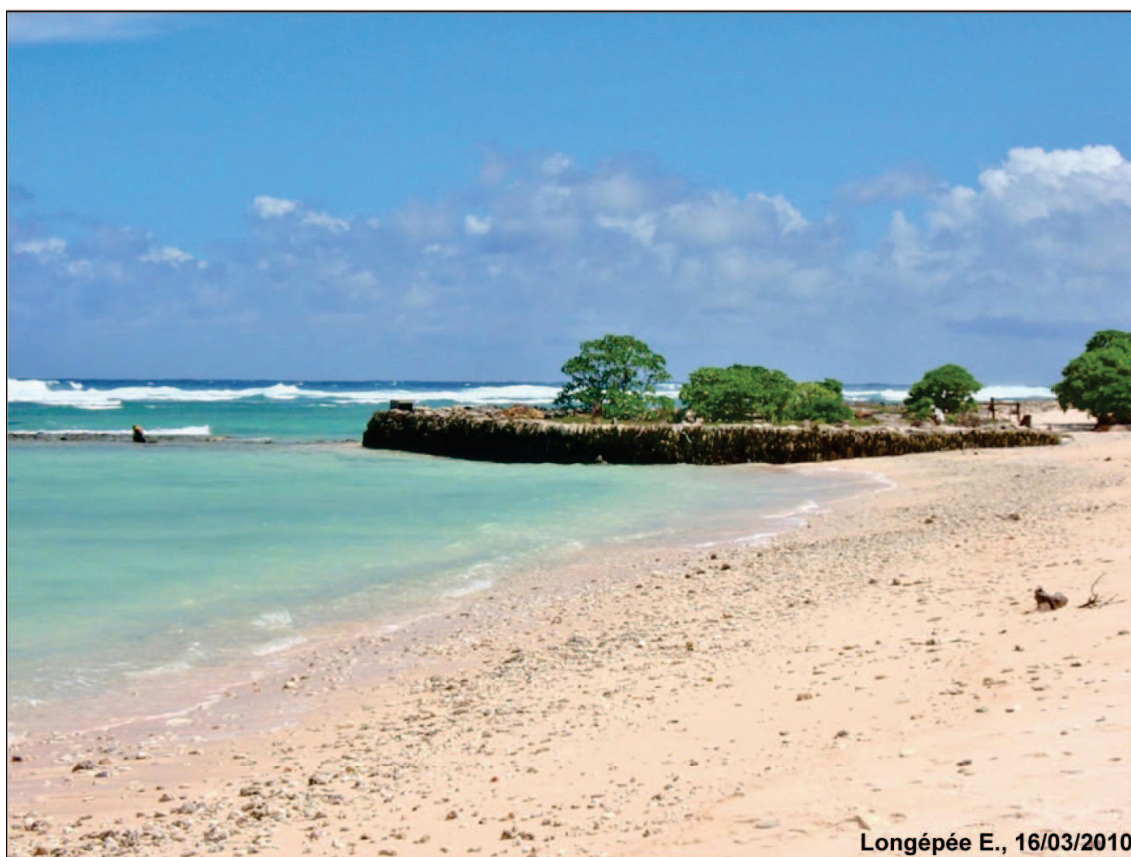
Photographie 20. Remblai d'un habitant de Temaiku empiétant sur plusieurs mètres sur le platier récifal côté océan.
