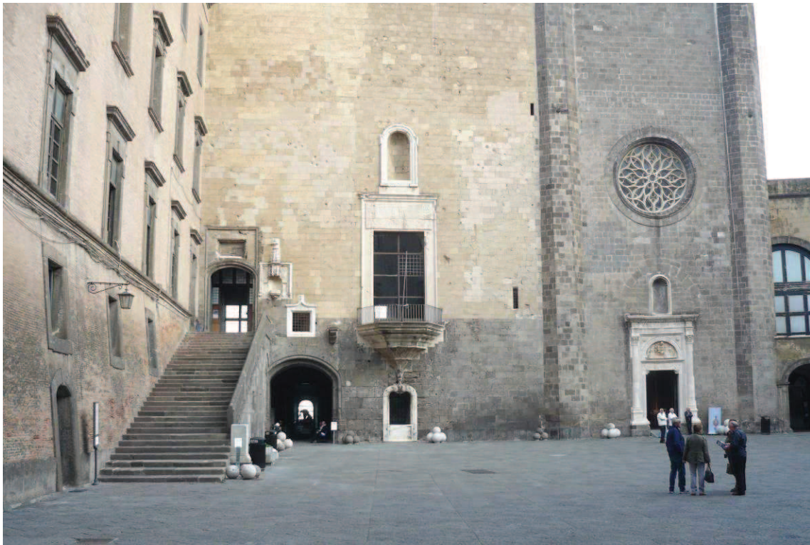
Vue de la cour depuis l'Ouest, l'escalier accédant à la salle des barons et la chapelle palatine
