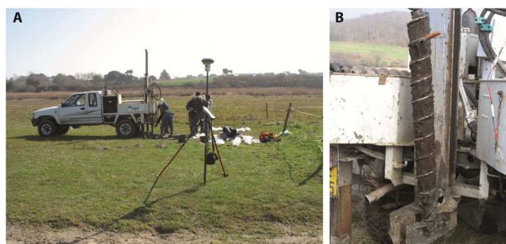
Fig.V.1.2 - Tarière à vis motorisée du BRGM.
