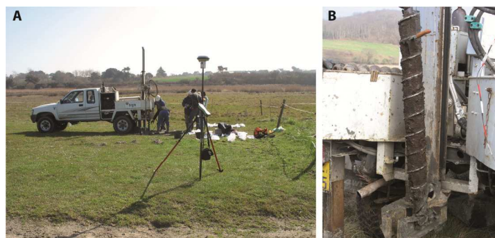
Fig.V.1.2 - Tarière à vis motorisée du BRGM.
