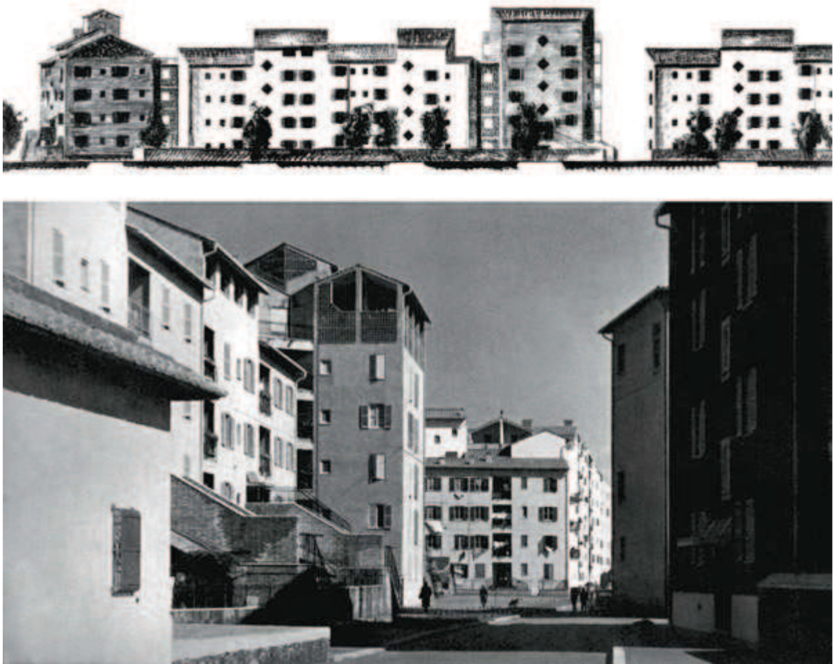
Figure 35 : Photographie et élévation des immeubles d’habitations Ina-Casa , rue Tiburtina, Rome, construits par Mario Ridolfi et Ludovico Quaroni, en collaboration avec les architectes M. Fiorentino, F. Gorio, M. Lanza, P.M. Lugli, G. Rinaldi, M. Valori, C. Aymonino, C. Chiarini, S. Lenci, C. Melograni et G.C. Menichetti, Rome, entre 1950 et 1954. Photographie d’Italo Insolera. Au-dessus : Élévation nord des immeubles sur la place et vue partielle de la grande place, quartier Tiburtino.
