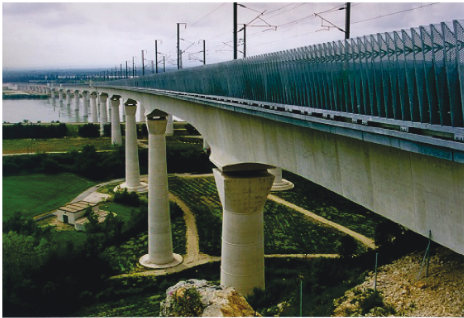
FIGURE 4 – Protection vis à vis des vents traversiers sur le viaduc des Angles au franchissement du Rhône - source SNCF -
