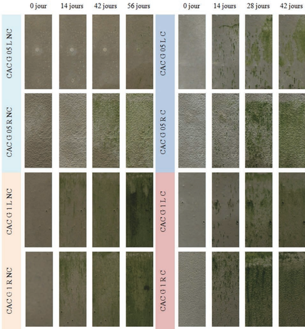
Figure III- 23 : Evolution des éprouvettes de CAC G durant leur biodétérioration _ Observation visuelle
