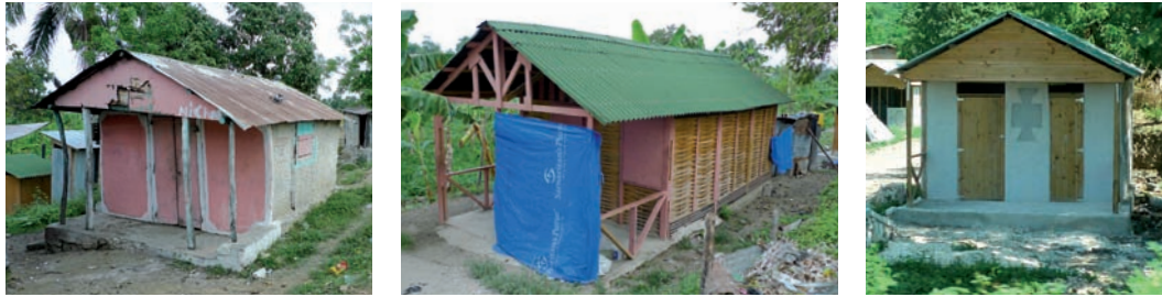
Fig.18: Haïti: a) habitat existant ; b) abri fourni après le séisme de 2010 ; c) pérennisation de l'abri par l'application d'un enduit en ciment
