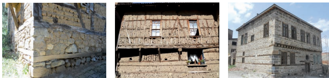
Fig.117: Utilisation des insertions horizontales (Turquie) : (a) en soubassement (Narlıca) ; b) pour les étages inférieurs (Sölöz) ; c) pour la totalité du bâtiment (Erzurum)
