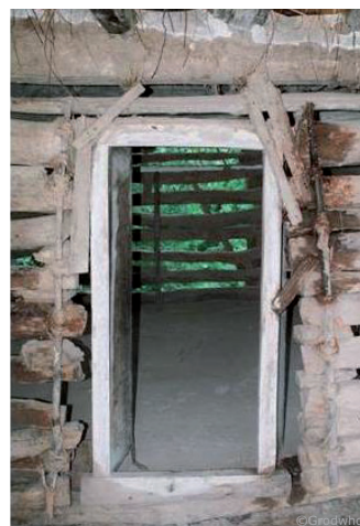
Système en zagmeh : stabilisation par clés verticales et cales en correspondance des ouvertures
