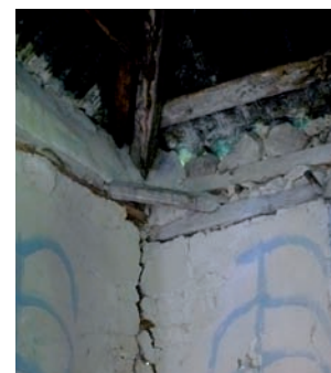
Contreventement de la poutre sablière
