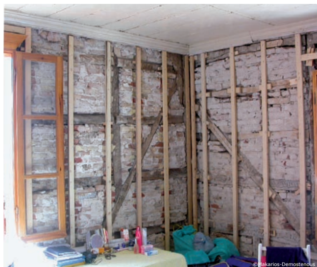
Ossature en bois à l'étage
