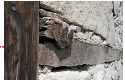
connexion traverse-poutre de chaînage
