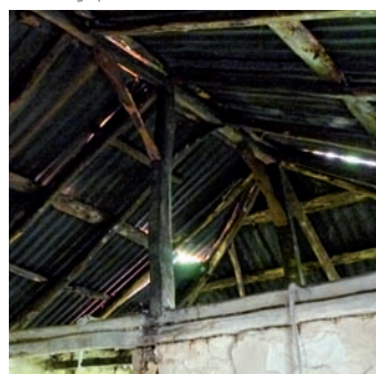
Contreventement de la structure de toiture
