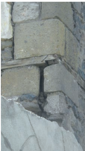
défaillance aux angles / mauvaise connexion entre chaînages horizontaux engendrant une perte de cohérence de la maçonnerie en pierres et un effondrement des angles du bâtiment
