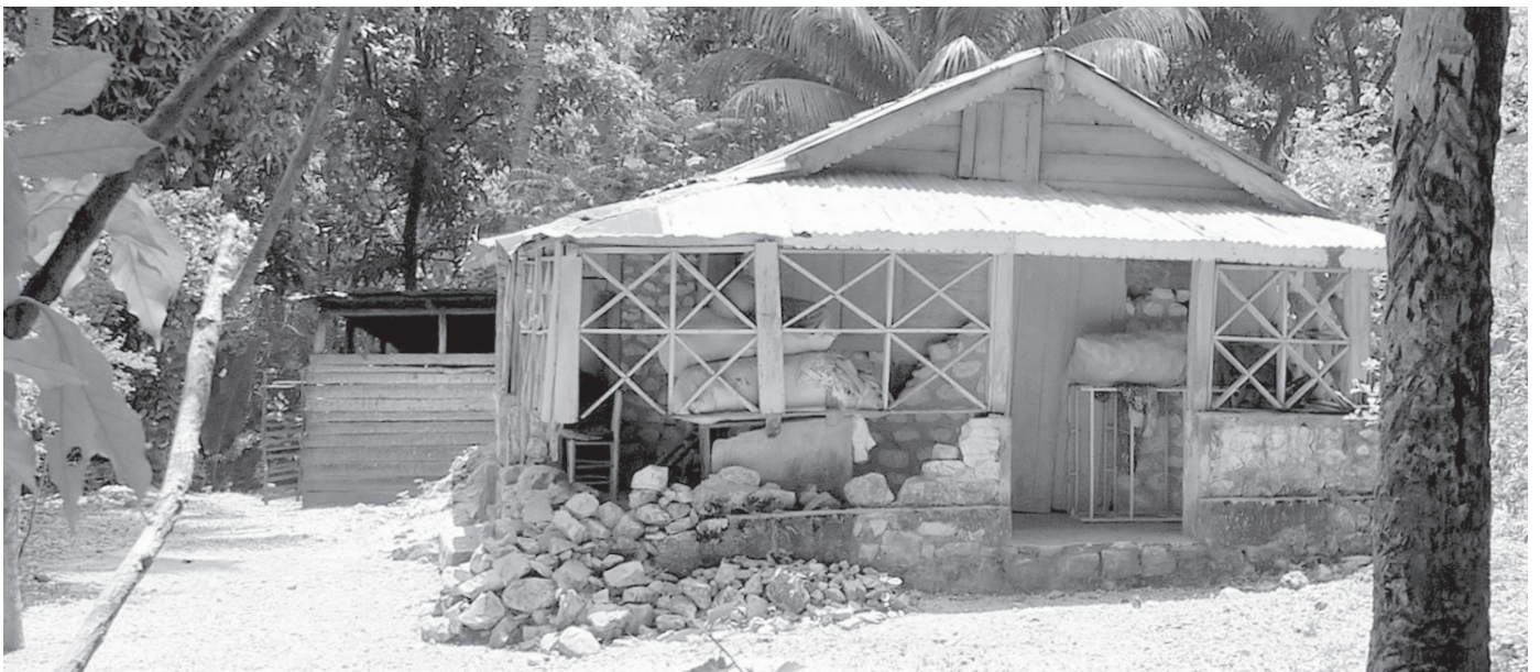
Fig.66: Haïti, Grande Rivière, effets du séisme de 2010 sur l'habitat vernaculaire
