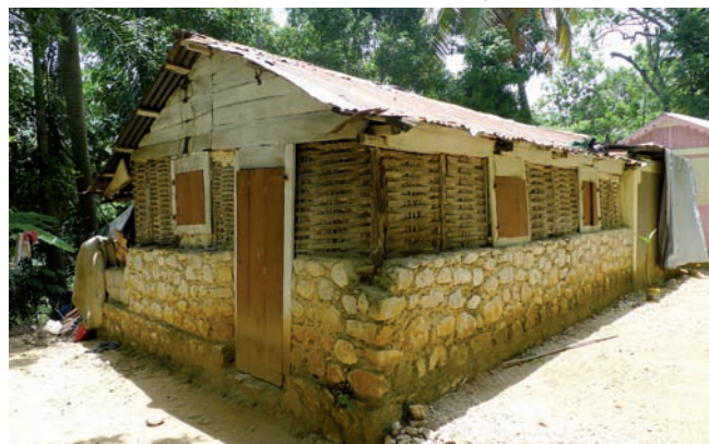
Mur à technique mixte: allègement structurel
