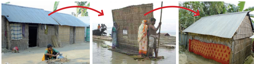
Fig.77: Bangladesh, région de Dinajpur, district de Gaibandha : construction déplaçable en matériaux légers (source photo b: www.sos-arsenic.net )
