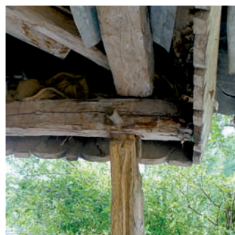
Assemblage par tenon et mortaise
