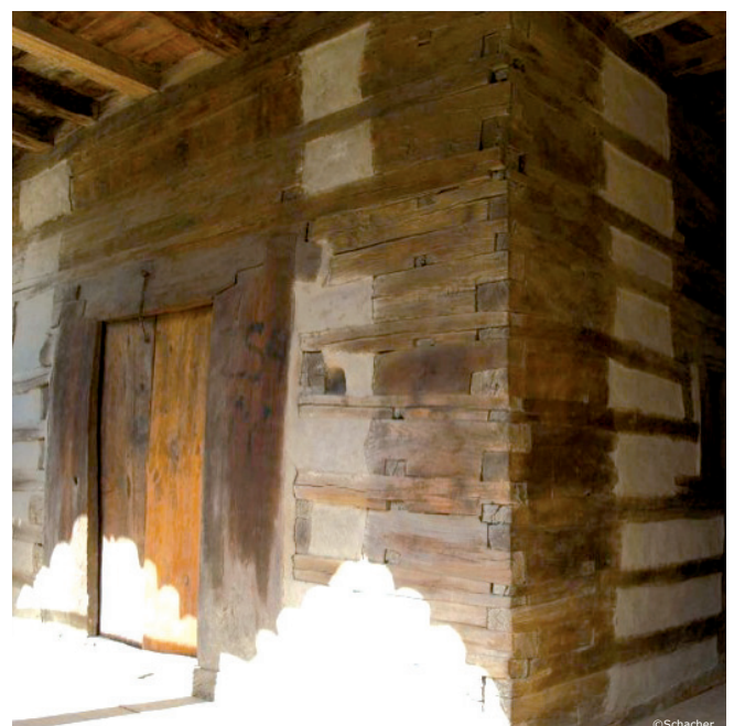
élément structurel à caractère parasismique: structure portante verticale © Hughes 1986
