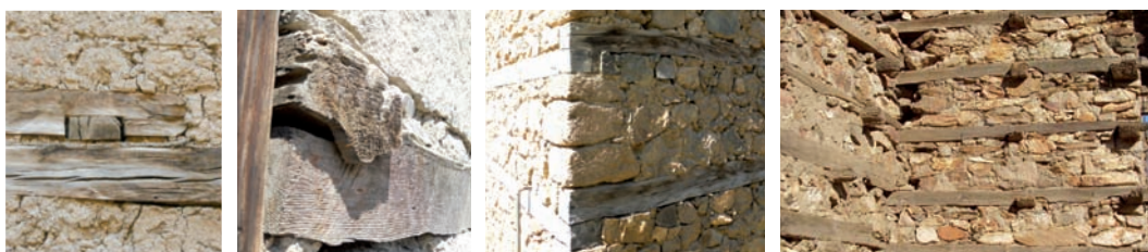
Fig.119: Insertions à échelle : a) connexions entre poutres et avec traverse (Cumalıkızık, Turquie) ; b) connexion entre poutre et traverse (Çamlıyamaç Köyü, Turquie) ; c) superposition aux angles du bâtiment (Narlıca, Turquie), d) aussi bien vers l'intérieur que l'extérieur (Cachemire Pakistanais, fort de Besham, 1750 ap. J.-C., crédits d : T. Schacher)
