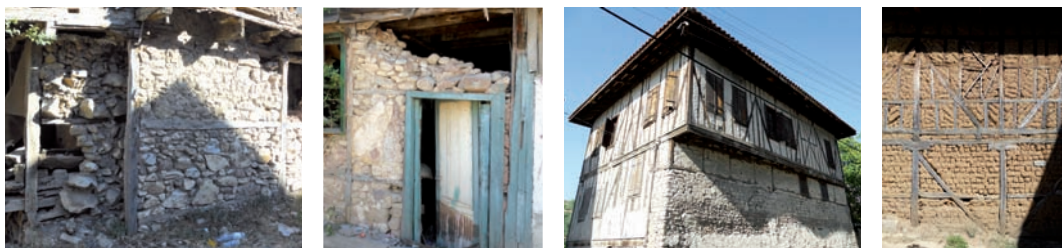
Fig.130: Turquie : a) insertions verticales en portique et horizontales à échelle (Tavşancıl) ; b) en cas d'écroulement partiel ou total de la maçonnerie les insertions verticales peuvent reprendre les charges des étages (Tavşancıl) ; c) utilisation ponctuelle en dessous des parties en saillies (Safranbolu) ; d) allègement structurel en vertical (Narlıca)
