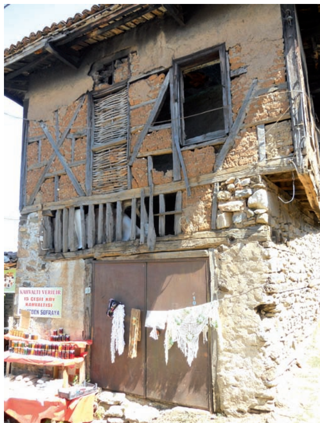
Cumalikizik Köyü : structure mixte avec rez-de-chaussée en maçonnerie étages en torchis et himis
