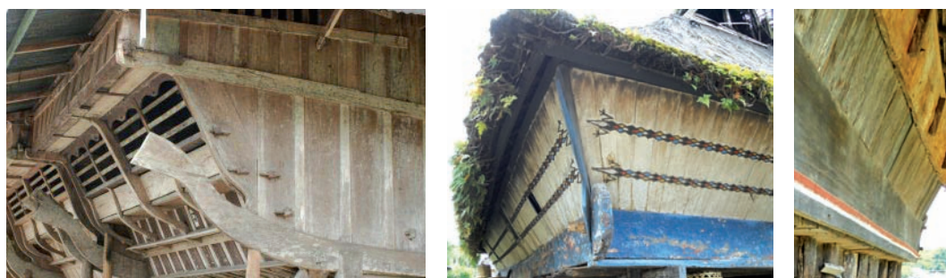
Fig.97: Indonésie, remplissage en planches : a) île Nias (crédits: Nata'alui Duha) ; b) Karo Batak, Berastagi ; c) Toba Batak, Danau Toba
