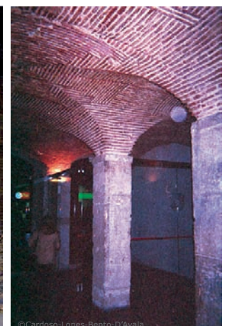
Rez-de-chaussée, structure en piliers et voûtes ©Cardoso-Lopes-Bento-D'Avila
