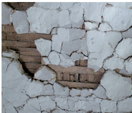
Clissage : lattes très serrées ne permettant pas la liaison entre le mortier des deux côtés du panneau
