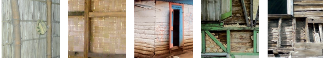
Fig.95: Parement souple : a) panneaux en roseaux (Dinajpur, Bangladesh), b) panneaux en lattes de bambou tressées (Nagaland, Inde) ; Bardage en planches : c) bardage extérieur (zones rurales, Haïti, crédits: E. Cauderay) ; d) bardage intérieur, chute du remplissage suite au séisme de 2010 (zones urbaines, Haïti, source: LANGENBACH, KELLEY, SPARKS, ET AL., 2010) ; e) double bardage avec cavité (Istanbul, Turquie)
