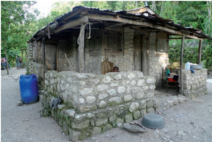
Grande Rivière : habitation avec structure en bois et remplissage en maçonnerie en pierre
