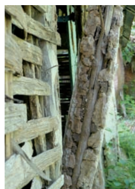
technique du klissage avec enduit sur les deux faces du mur
