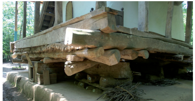
Détails des fondations en piles de rondins ©Grodwhol
