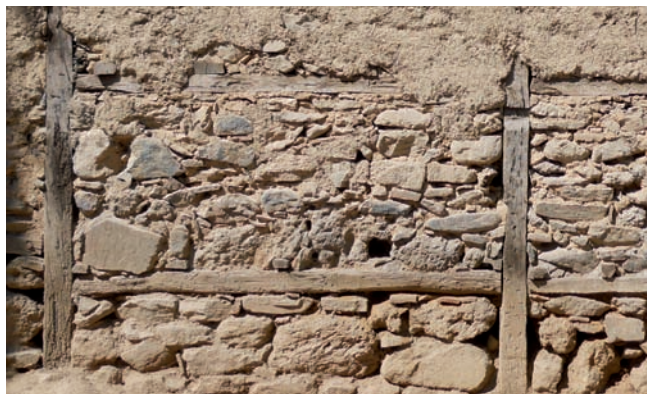
Bursa, insertions horizontales et montants verticaux Narlica
