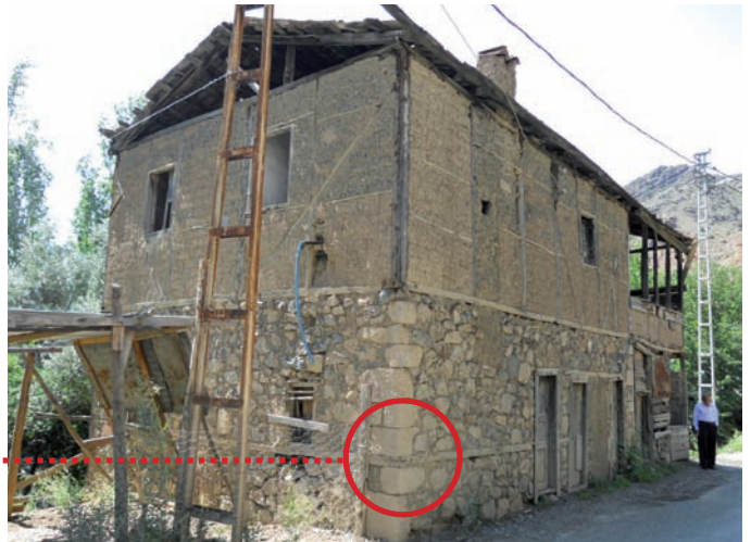
rez-de-chaussée en maçonnerie en pierre avec mortier en terre et chaînages horizontaux en bois étage léger avec ossature en bois et remplissage en maçonnerie de briques en terre crue
