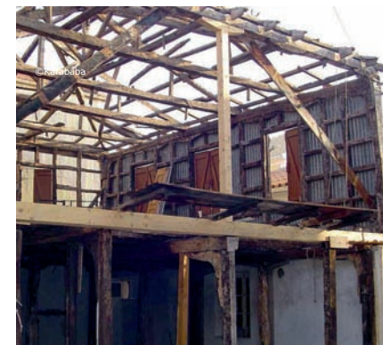
Système porteur à ossature bois
