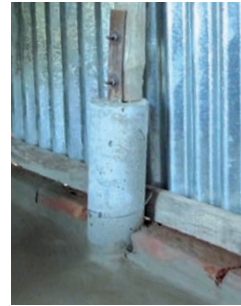
Fig.12: Région de Dinajpur, protection de la base des poteaux selon techniques et coûts différents : a) bâche en plastique et traitement avec créosote ; b) base en ciment.
