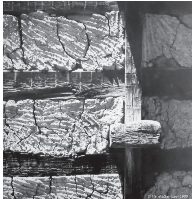
Clé et agrafe reliant verticalement la structure en poutres superposés
