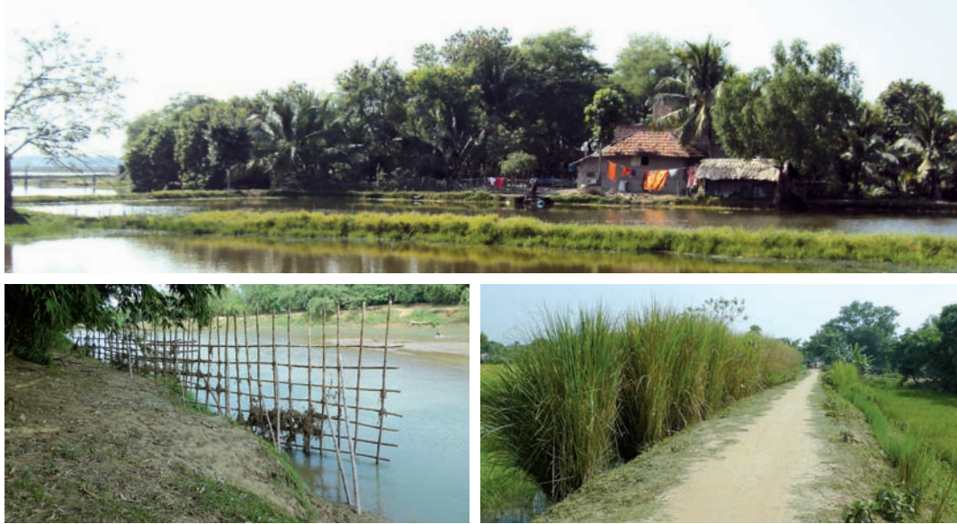
Fig.79: Bangladesh : a) protection envers les vents cycloniques : barrière végétale ; réduction de l'érosion des berges lors des inondations : b) grille de protection, c) plantation de vétiver pour la stabilisation de la digue
