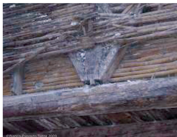
Détail d'assemblage: structure du plancher - contreventement
