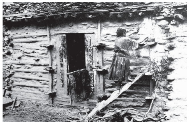
Application d'un badigeon de terre
