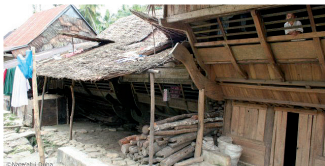
Effondrement de la substructure lors du séisme de mars 2005: les poteaux empilés sur le côté sont réutilisables pour élever à nouveau la boîte d'habitation
