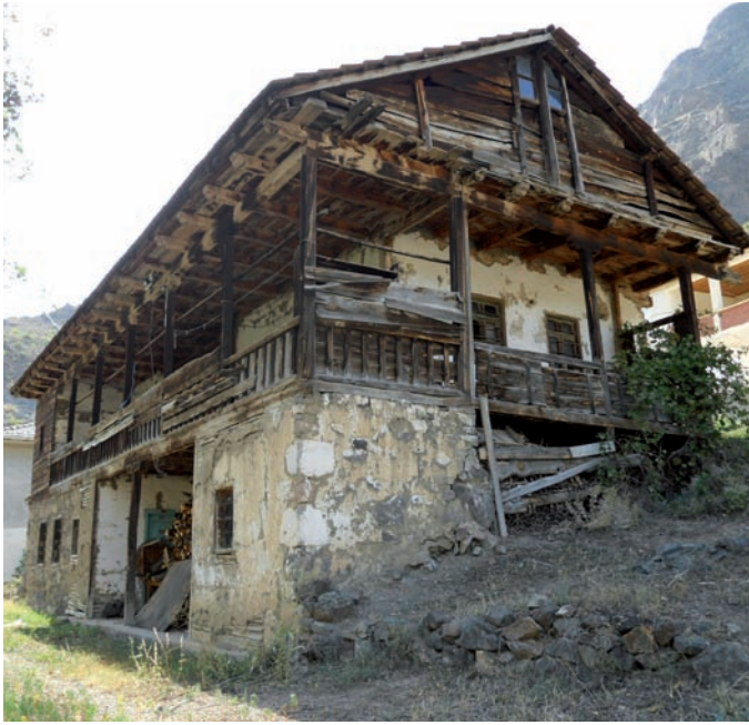
structure primaire en maçonnerie en pierre avec mortier en terre et charpente en bois
