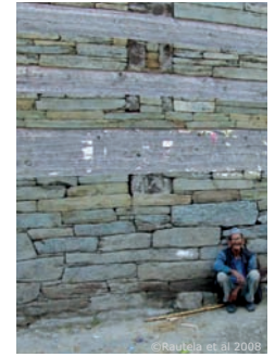
Plateforme de soubassement
