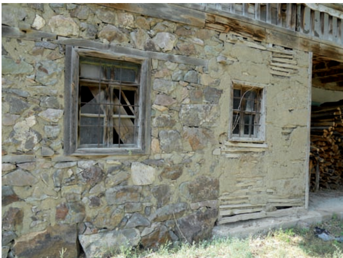
extension légère avec ossature bois, lattis cloués et remplissage en terre
