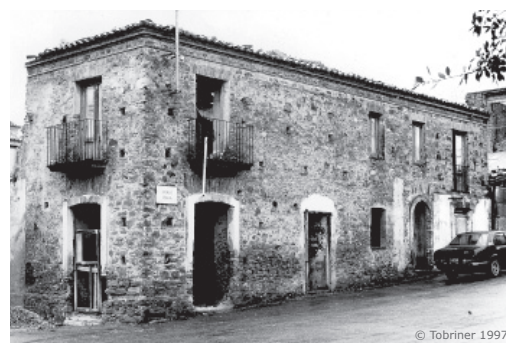
Bâtiment avec le système baraccato , Filadelfia, province de Vibo Valentia
