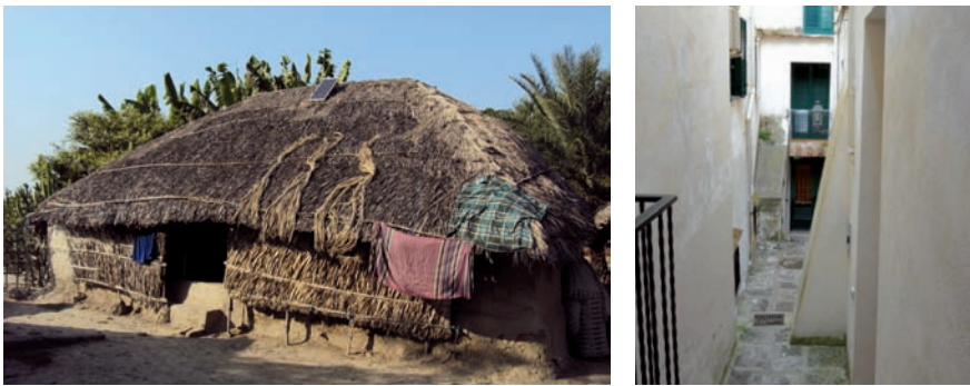
Fig.71: a) Forme trapue et toiture à quatre pentes : aérodynamisme morphologique envers les vents cycloniques (Khulna, Bangladesh) ; b) Contrefort réduisant la largeur du passage : renforcement ponctuel envers les sollicitations sismiques (Atrani, Italie)
