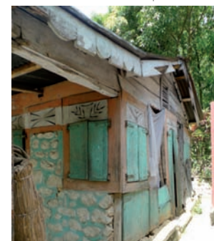
Planches perforées en dessous de la toiture
