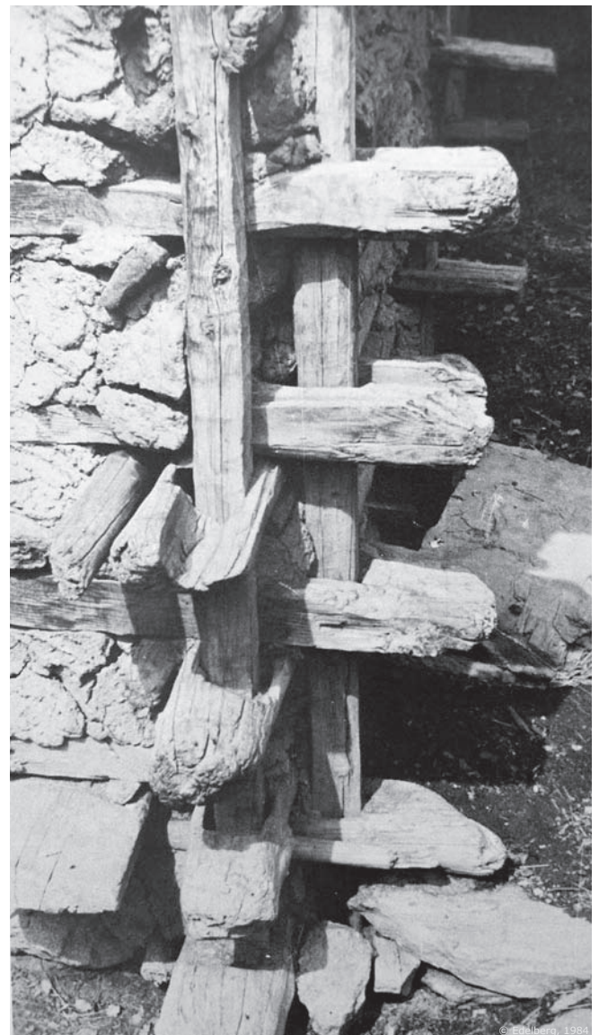
Clés de stabilisation à l'angle du bâtiment conférant unité à l'empilement des poutres
