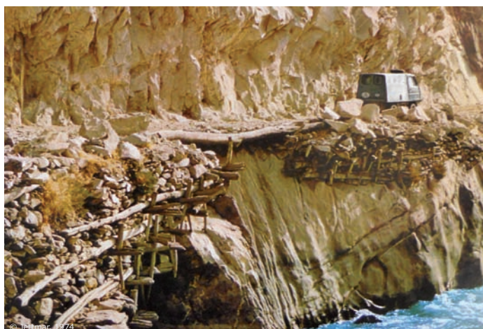
Utilisation du système d'agrafes avec clés verticales pour la stabilisation de routes
