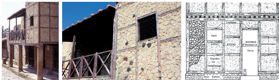
Fig.85: Herculanum (Italie), casa a graticcio : a) vue d'ensemble (crédits: R. Ulrich) ; b) structure de l'étage (crédits: P. Finkle) ; c) composants structurels (source: VAN KRIMPEN-WINCKEL, 2009)
