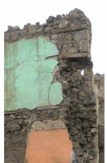
maintien en cas d'effondrement / les chaînages horizontaux empêchent l'écroulement de la partie supérieure en maçonnerie, évitant ainsi un effondrement complet du mur et facilitant la réparation de la partie endommagée
