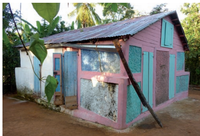
Renforcement aux angles du bâtiment
