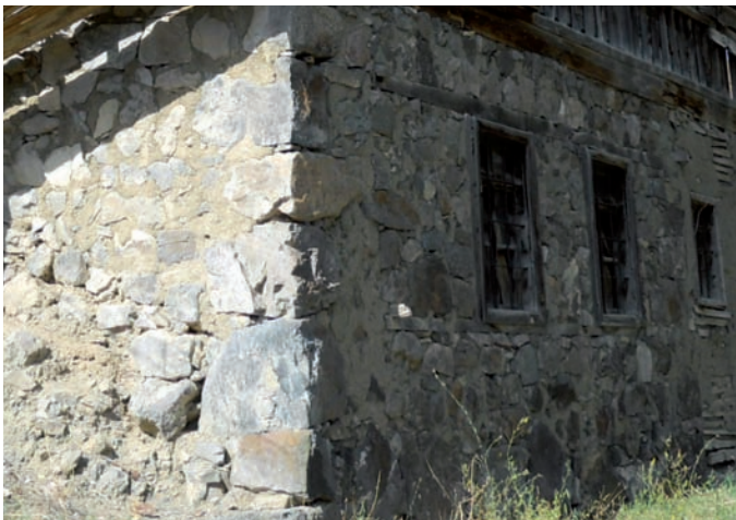
poutres horizontales en bois intégrées à la maçonnerie en correspondance des ouvertures, sans continuité sur le pourtour du bâtiment
