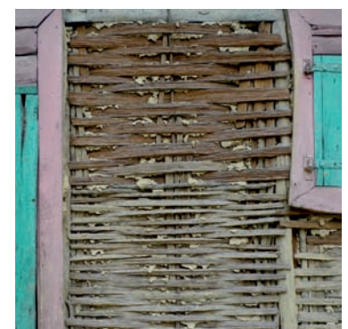
technique du klissage avec enduit uniquement à l'intérieur
