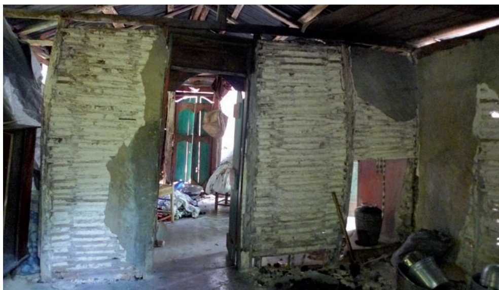
Endommagement de parois intérieures et extérieures lors du séisme du 12 janvier 2010
