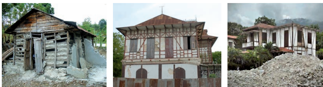
Fig.86: Haïti, effets du séisme de janvier 2010 : a) habitat rural (crédits: A. Douline) ; maisons gingerbread (Port-au-Prince) : b) chute de portions de remplissage de l'ossature (crédits: S. Kelley), c) bâtiment faiblement endommagé derrière le reste d'un structure en béton armé (crédits: R. Langenbach)
