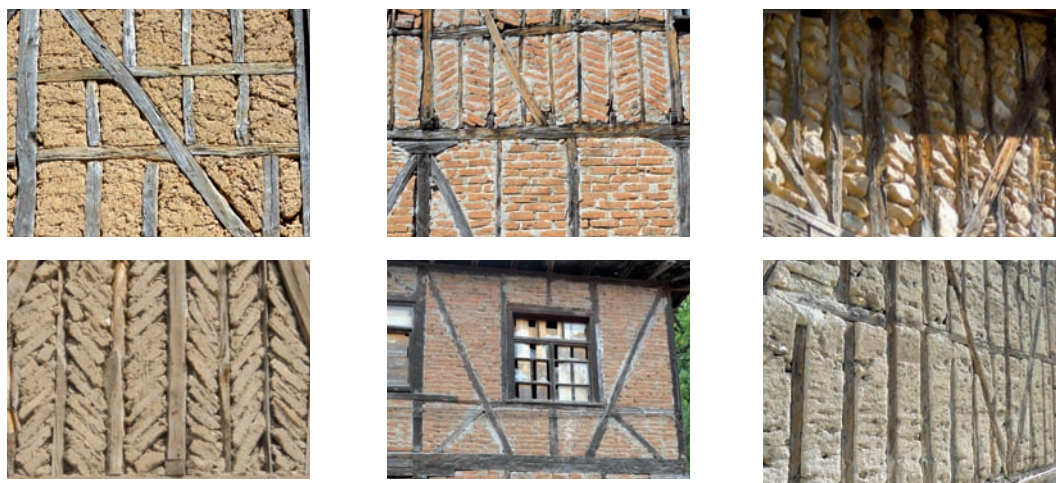
Fig.99: Variantes de remplissage et de répartition de la structure primaire ( hımsı , Turquie) : a et b) briques en terre crue ; b et c) briques en terre cuite ; c et d) pierres
