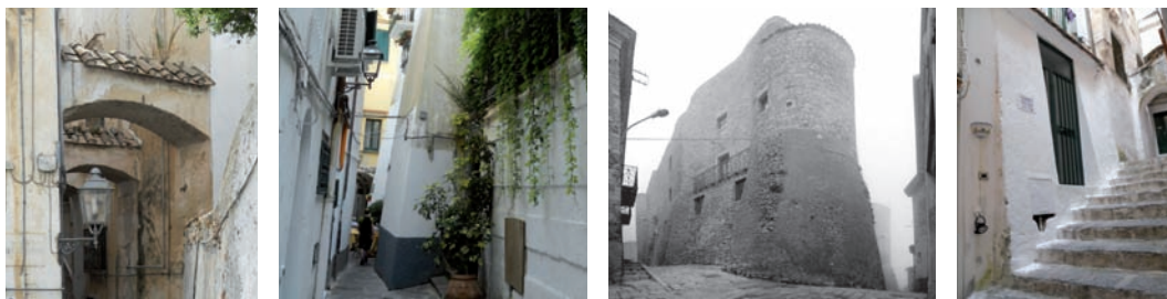
Fig.111:Renforts (Italie): a) entre bâtiments (Atrani) ; b) contrefort ponctuel à l'angle du bâtiment et réduisant la largeur du passage (Atrani) ; c) contrefort continu (Bonefro, crédits: R. Langenbach) ; d) embrasure des ouvertures en biais (Atrani)
