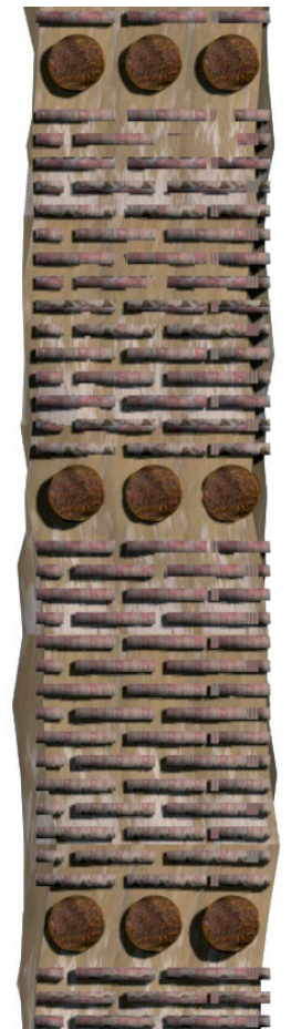
Mur avec insertions horizontales en bois ©Abdessemed Foufa-Benouar 2008
