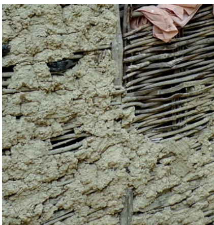
Clissage : lattes très serrées ne permettant pas la liaison entre le mortier des deux côtés du panneau
