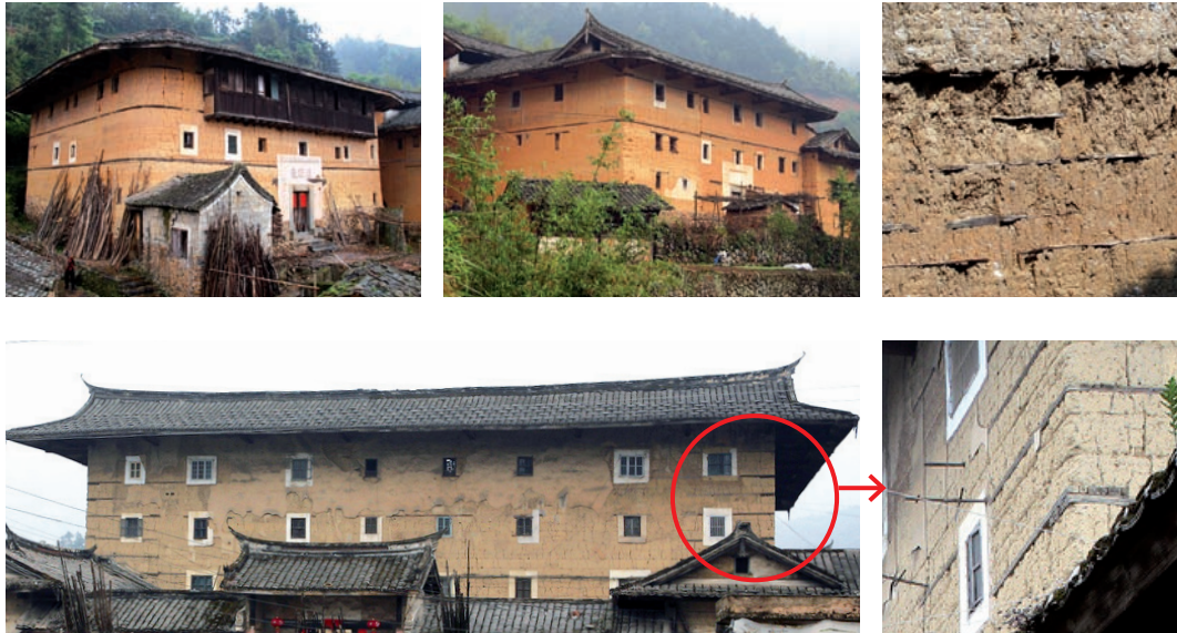
Fig.132: Insertions en bois (source: HANMIN, 2010) : a et b) insertions espacées (Nanjing) ; c) insertions internes rapprochées visibles suite à l'érosion du mur ; d) insertions multiples avec (e) renforcement aux angles (bâtiment Schanchenglou)
