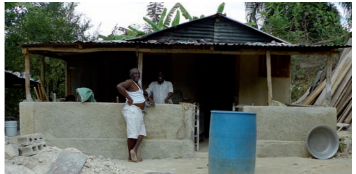
Angibeau: maison reconstruite après le séisme de 2010 par le propriétaire sans aide extérieure (photo prise en février 2011)
