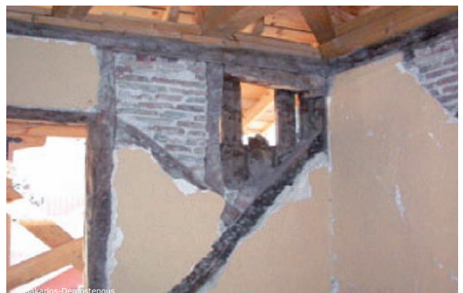
Effets du séisme du 14 août 2003 : écroulement du remplissage en maçonnerie aux angles des cadres en bois
