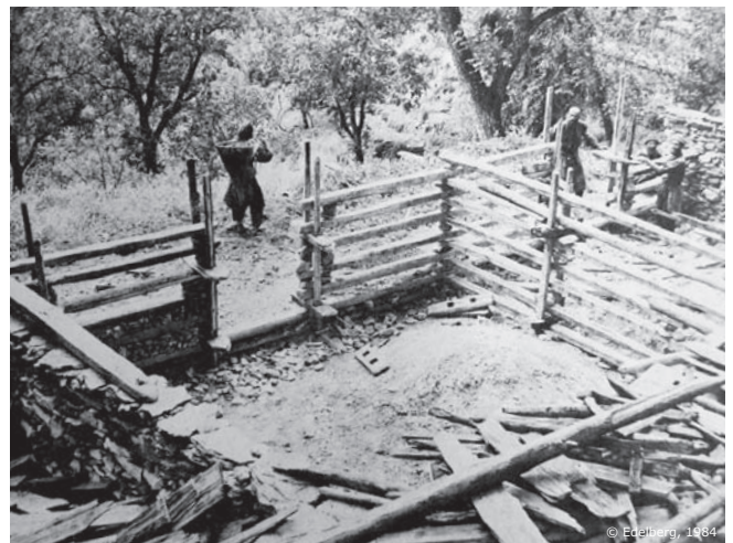
© Edelberg, 1984 Structure en poutres horizontales agrafées
