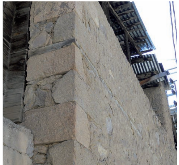
maçonnerie en pierre sèche avec chaînage horizontal
