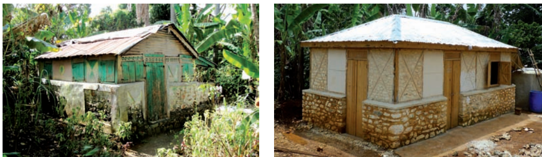
Fig.13: Zone de Kenscoff (Haïti), reconstruction post-séisme : a) habitat existant (crédits: J. Hosta) ; b) habitation nouvelle
