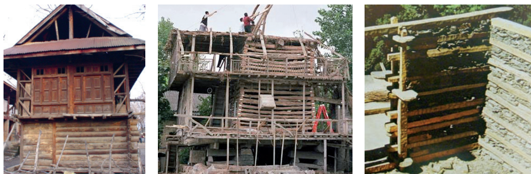
Fig.89: Cages en ossature :
