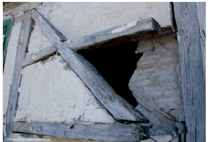
Effets du séisme du 14 août 2003 : effondrement du remplissage en maçonnerie en hors plan
