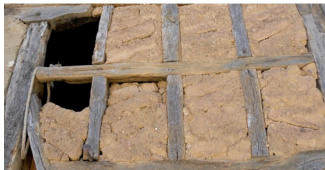
Narlıca : structure en himis (briques en terre crue)
