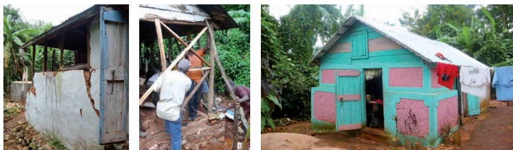
Fig.10: Cap Rouge (Haïti), exemple d'intervention sur une habitation existante (crédits: O. Moles):
