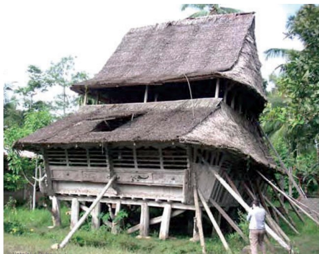
Étayage après le séisme de mars 2005
