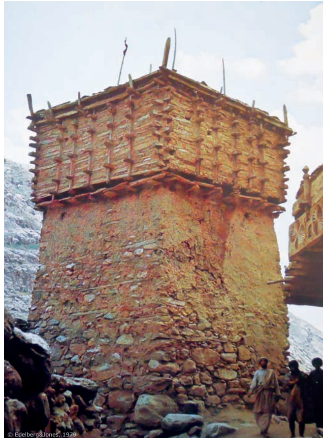
Tour d'observation fortifiée : étage en empilement de poutres agrafées sur corps en maçonnerie porteuse avec insertions horizontales en bois
