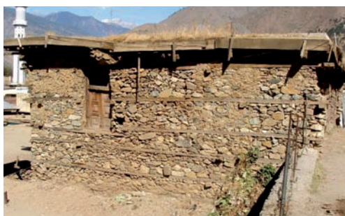
Fig.103: Cachemire pakistanais, après le séisme de 2005 : deux constructions réalisées avec des matériaux et des techniques similaires mais n'intégrant pas les mêmes dispositifs : a) complètement effondrée (crédits: O. Moles), b) quasiment intacte (crédits: T. Schacher)
