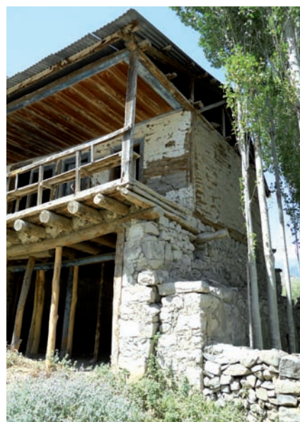
structure de la galerie / assemblages avec entailles arrondies
