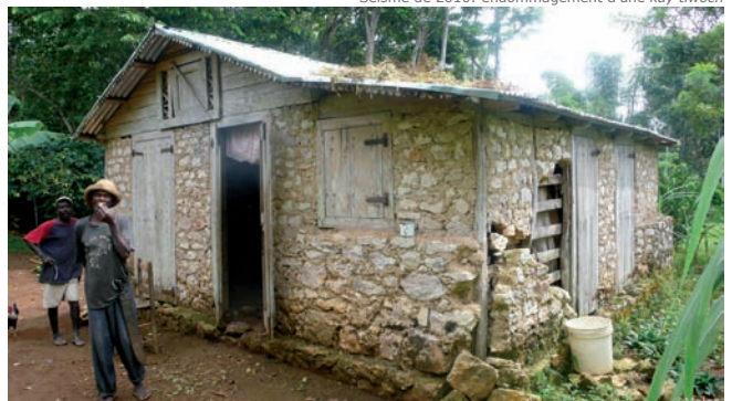
Séisme de 2010 : endommagement d'une kay tiwoch
