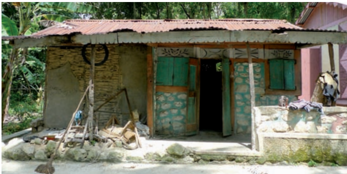
Grande Rivière : maison ayant survécu au séisme de 2010, avec structure en bois et remplissage en partie en maçonnerie de pierres et en partie en clissage avec mortier en terre
