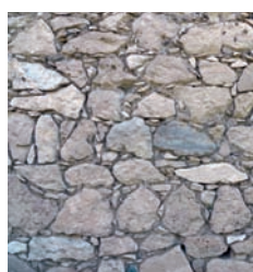
Fig.110: Bourrage : a) en joints fins, Kadibükü (Turquie) ; b) en piles, Délos (Grèce, source: Wikipedia) ; c) étendu, Chypre (source: MEDA CORPUS, 2011)
