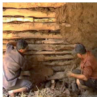
Remplissage et pose d'un enduit de base en terre
