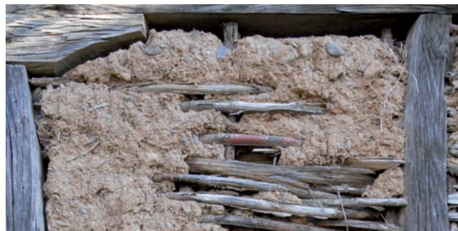
Değirmendere : remplissage en torchis
