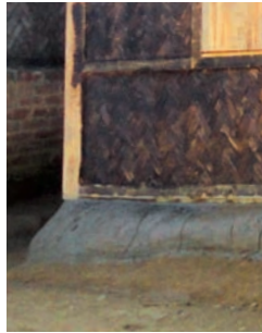
Fig.11: Région de Chittagong, adaptation à la typologie constructive (crédits: O. Moles) : a) habitation sur plateforme, contreventement de la structure portante ; b) habitation sur soubassement, masse d'usure
