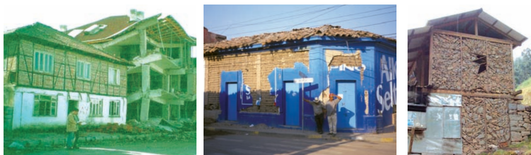
Fig.87: Effets des séismes : a) Turquie 1999, construction vernaculaire faiblement endommagée à côté d'un bâtiment en béton armé effondré (source : DOGANGÜN, TULUK, LIVAOĞLU, et al.) ; b) El Salvador 2001, détachement des enduits (crédits : A. Douline); c) Pakistan 2005, chute d'une portion de remplissage (crédits : T. Schacher)
