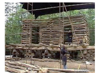
Système en zagmeh : stabilisation par clés verticales
