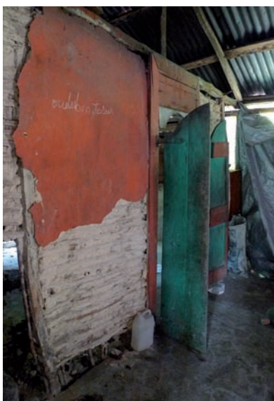
Endommagement de parois intérieures et extérieures lors du séisme du 12 janvier 2010
