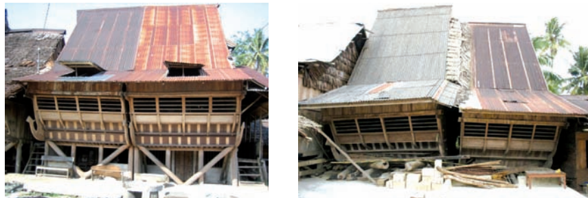
Fig.83: Habitat vernaculaire, île de Nias (Indonésie) : avant et après un séisme de M 8.7 en mars 2005, la substructure s'est effondrée mais l'espace d'habitation est resté intact (crédits: B. Wolff)
