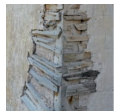
lattis avec remplissage en pierres et mortier de terre
