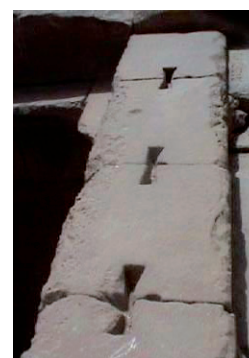
Fig.109: (gauche) a) Grèce, montage des blocs constituant le Parthénon (source: STIROS, 1995) ; b) Egypte, connexion entre blocs de la même rangée (source: NIKER 2010)
