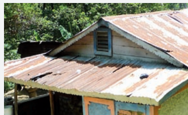
Fig.54: a) clôture de la galerie agissant comme contreventement ; b) frise décorative brise-vent (pour la toiture et la galerie) et grenier fermé avec toiture à deux pentes
