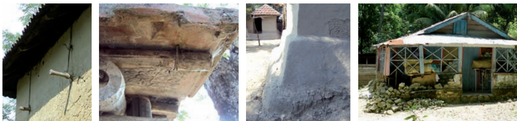
Fig.75: Bangladesh: a) ancrage de la poutre sablière ; b) stabilisation des tuiles par ligature ; c) masse d'usure en double marche ; d) Haïti : clôture de la galerie agissant comme un système de contreventement
