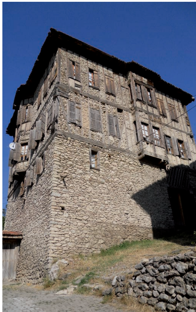
Safranbolu Çarşı : immeuble à tour avec étages inférieurs en maçonnerie en pierre et étages supérieurs en himis (pierres)
