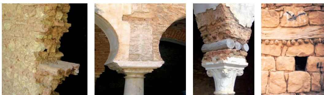
Fig.122: Insertions en rondins (Algérie) : a) traversant l'épaisseur du mur ; b) à la base des arcs et (c) en tête de colonne ; d) variante de la région d'Arès (sources : a) ABDESSEMED FOUFA, BENOUAR, 2008 ; b et c) FOUFA, 2007 ; d) MEDA CORPUS, 2011)
