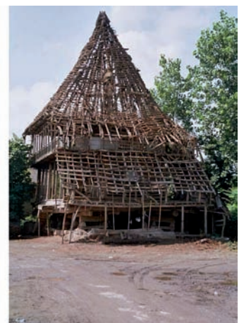
Phases de montage de la structure en bois ©Grodwohl
