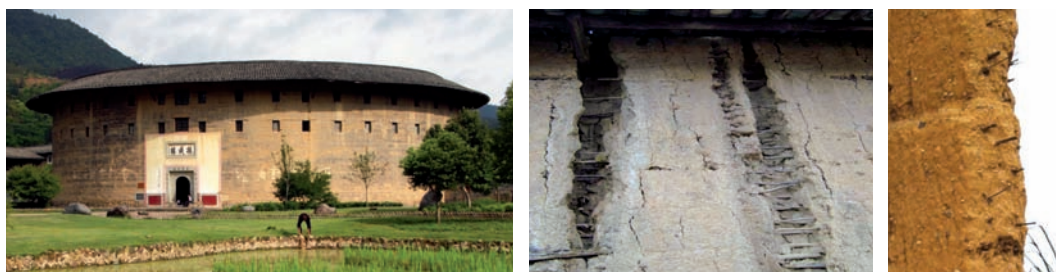
Fig.131: Chine, tulou : a) vue (source: HANMIN, 2010); b) insertions visibles suite à l'érosion du mur (source: LIANG, HOTA, 2009) ; c) insertions en bambou (crédits: M. Chamodot- B. Cloquet)
