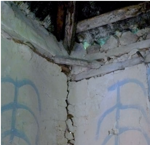
Des contreventements horizontaux aux quatre angles de la poutre sablière solidarisent la structure, tandis qu'au niveau de la toiture, des contreventements diagonaux entre la poutre faîtière et les ponçons des fermes assurent la stabilité de la charpente.
