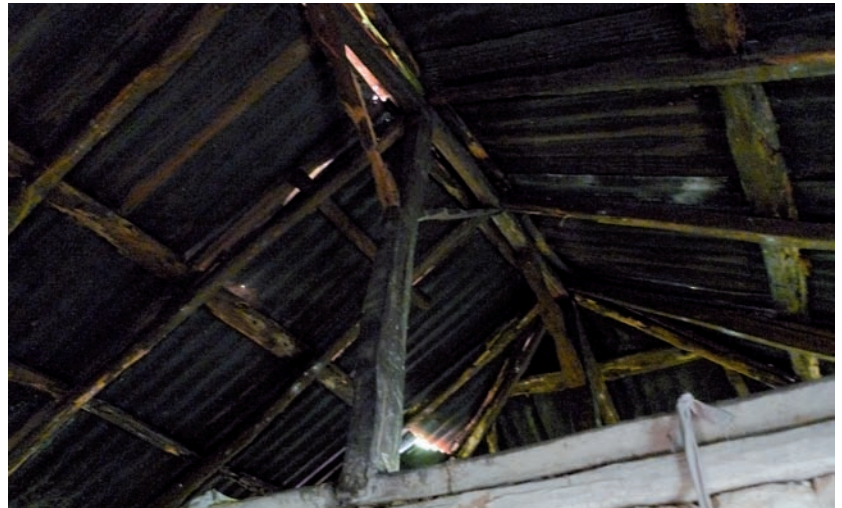
Des contreventements horizontaux aux quatre angles de la poutre sablière solidarisent la structure, tandis qu'au niveau de la toiture, des contreventements diagonaux entre la poutre faîtière et les ponçons des fermes assurent la stabilité de la charpente.
