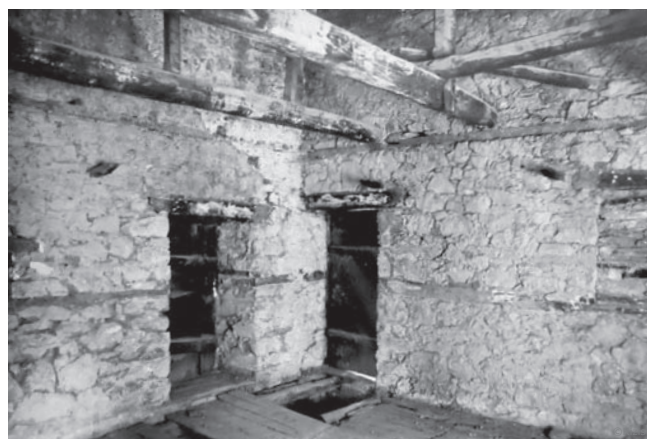
insertions horizontales : disposition et connexions ©Kizis
