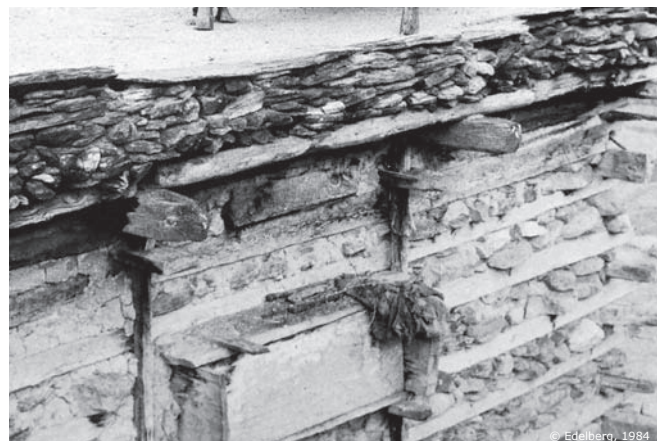
© Edelberg, 1984 Structure de toiture : superposition de couches de couverture, solives en saillie Murs : agrafes et croisement des poutres structurelles
