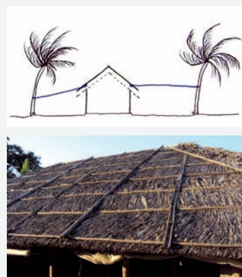
Fig.47: a) haubanage de la toiture ; b) stabilisation d'une toiture en chaume
