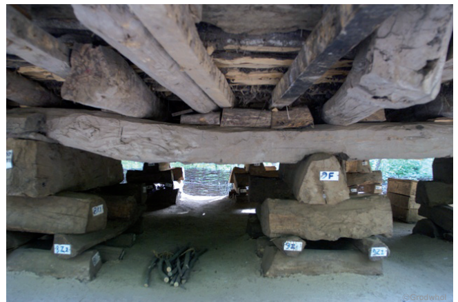
Surélévation par empilement de rondins
