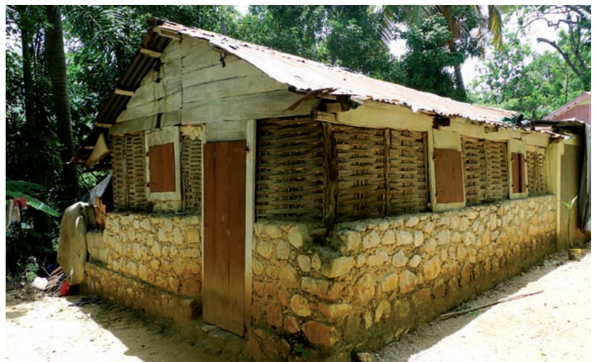
La réduction progressive de l'épaisseur des murs et l'utilisation de matériaux plus légers pour la partie supérieure permettent de protéger les occupants, en cas d'effondrement partiel, ainsi que de réduire le poids du mur en baissant le centre de gravité de la construction.
