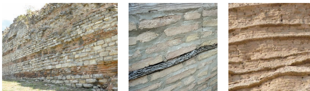
Fig.123: a) bandes en briques cuites entre rangées en maçonnerie de pierres (mur théodosien, Istanbul) ; nattes en roseaux dans maçonnerie en briques de terre crue : b) Turkménistan (crédits: D. Gandreau) et (c) ziggourat Dur-Kurigalzu en Irak (crédits: T. J. Tritten)
