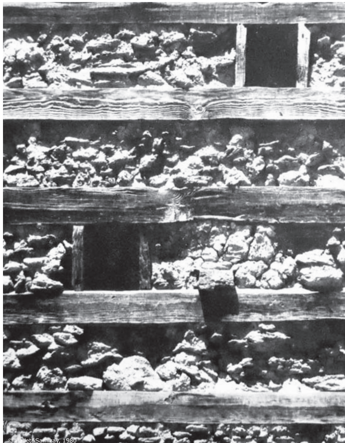
© Let-Sammy, 1980 Ouvertures entre les poutres horizontales
