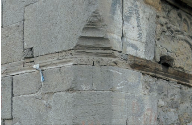
angles / maçonnerie appareillé en angle biseauté avec élément en biais de connexion entre chaînages extérieurs perpendiculaires (rez-de-chaussée, façades sur rue)
