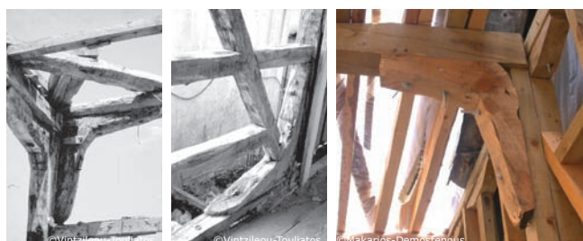
Équerres de raidissement de l'ossature en bois
