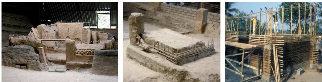
Fig.133: Joya de Céren, site archéologique : a) vestige d'une habitation (source: UNESCO) ; b) détail du principe constructif (source: arqueoruta.blogspot.com) ; c) construction en bahareque céren réalisée suite au séisme de 2001 au Salvador (crédits: W. Carazas-Aedo)
