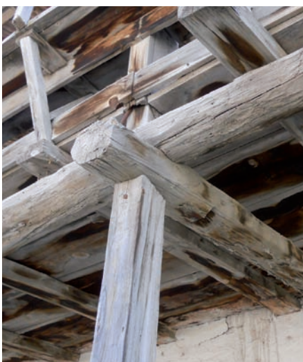
structure de la galerie / assemblages avec entailles arrondies
