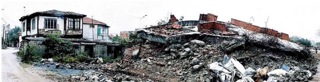
Fig.101: Turquie : construction en hımış ayant survécu au séisme de Kocaeli de 1999, en revanche le bâtiment voisin en béton armé s'est complètement effondré (crédits: R. Langenbach)
