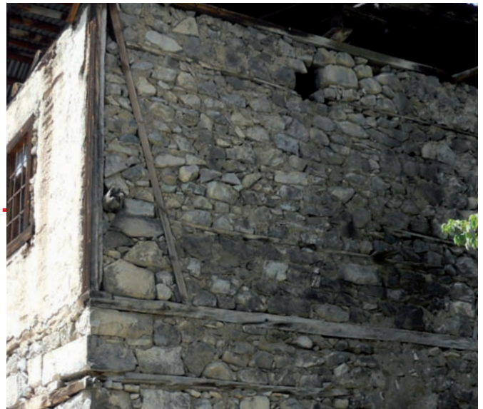
rez-de-chaussée en maçonnerie avec chaînages en bois, étage en maçonnerie en pierre avec planches horizontales en bois et angles renforcés par des poteaux et diagonales
