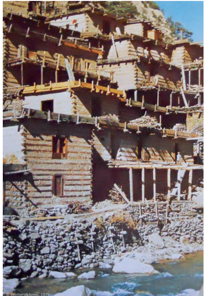
Clés et agrafes pour la stabilisation des berges des rivières et des structures de toiture des habitats
