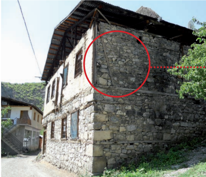
rez-de-chaussée en maçonnerie avec chaînages en bois, étage en maçonnerie en pierre avec planches horizontales en bois et angles renforcés par des poteaux et diagonales
