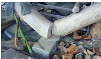
©Nata'alul Duha Contreventements diagonaux sur fondation en pierre
