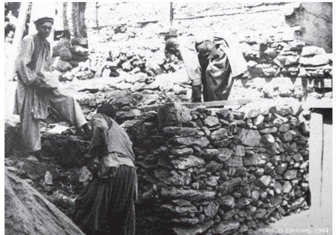
© Edelberg, 1984 Préparation de l'assise du bâtiment
