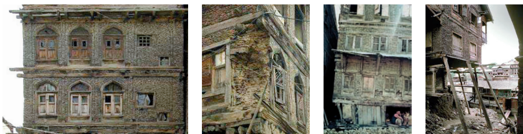
Fig.121: Système taq , Srinagar (Inde, crédits: R. Langenbach) : a) modularité ; b) les poutres horizontales en bois solidarisent le mur composé de matériaux disparates ; c) bâtiment ayant survécu au séisme de 1885, en dépit de l'important tassement du sol la structure ne s'est pas effondrée ; d) construction partiellement endommagée, les insertions en permettent un étayage ponctuel grâce à leur fonction de laçage de la maçonnerie
