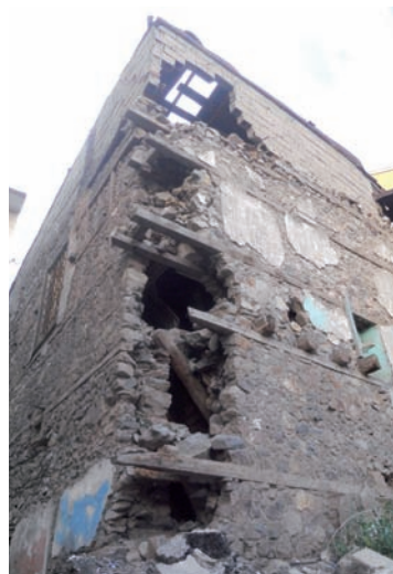
défaillance aux angles / mauvaise connexion entre chaînages horizontaux engendrant une perte de cohérence de la maçonnerie en pierres et un effondrement des angles du bâtiment
