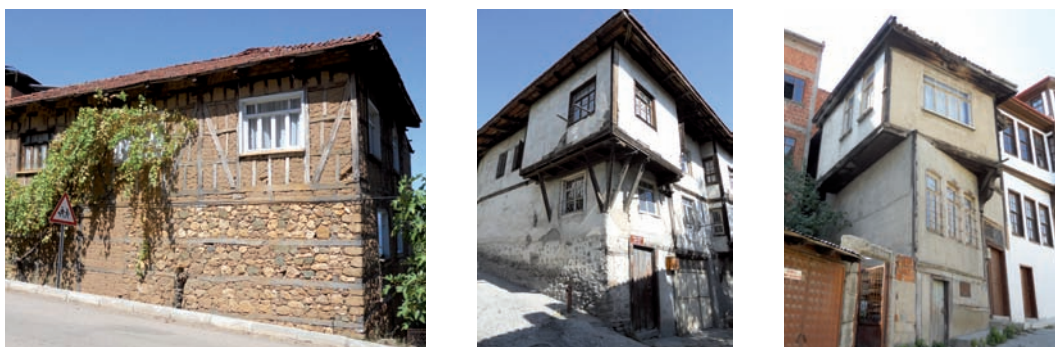
Fig.88: Turquie : a) association à une maçonnerie porteuse (Narlıca) ; volumes en saillie (Safranbolu) ; c) indépendance des structures des étages (Kastamonu)
