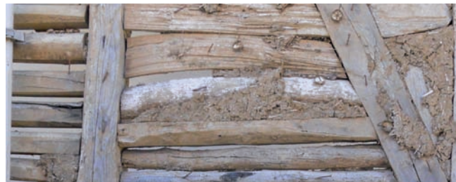
Saraylı Köyü : remplissage en dizeme (rondins)
