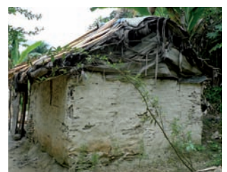
technique du klissage avec enduit : abri réalisé après le séisme de 2010
