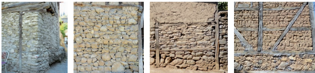
Fig.129: Variantes (Turquie) : a) insertion ponctuelle (Safranbolu) ; b) insertions horizontales fines et déconnectées de celles verticales (Çerçen) ; c) insertions avec épaisseur équivalent (Bursa) ; d) insertions diagonales (Narlıca)
