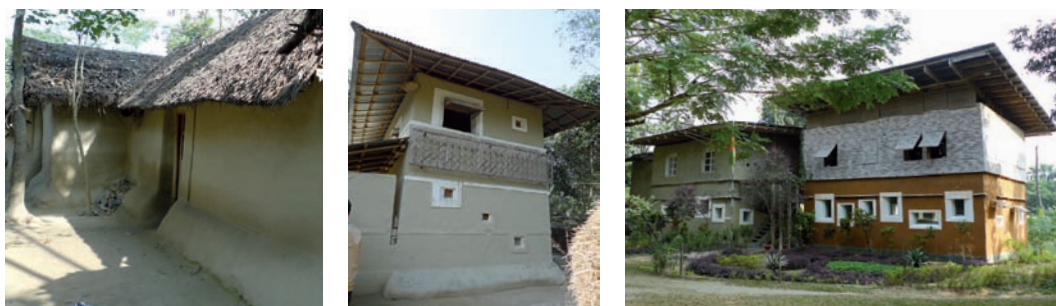
Fig.14: Bangladesh, réinterprétation de la construction en terre et bambou : a) habitat existant ; b) nouvelle habitation ; c) école
