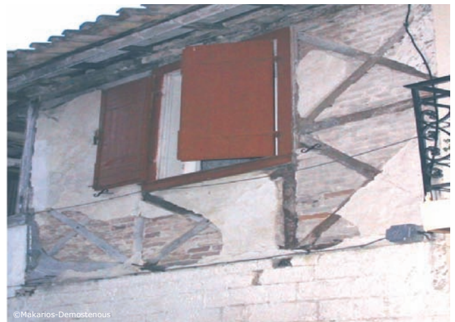
Effets du séisme du 14 août 2003 : détachement de l'enduit à l'étage supérieur
