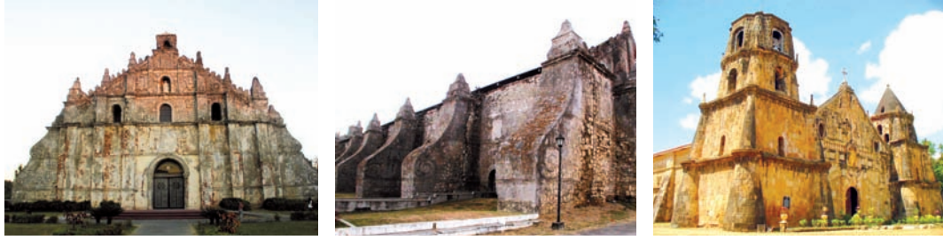
Fig.112: Earthquake Baroque, Philippines : église de San Agustin, a) façade trapue et b) renforts ponctuels latéraux; c) église de Santo Tomas de Villanueva, clochers d'angle (sources : a et b) architecturalmoleskine.blogspot.com ; c) skyscrapercity.com)
