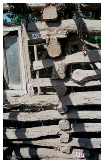
Système en zagmeh : entrecroisement des rondins composant des parois perpendiculaires
