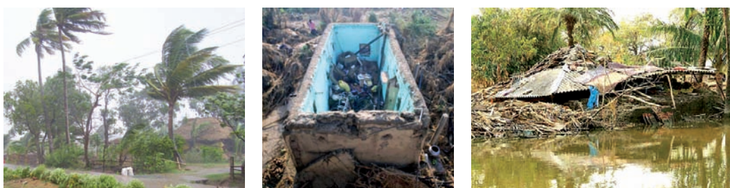
Fig.138: Phénomènes cycloniques : a) vents violents et pluies torrentielles ; effets du cyclone Aila, 2009 (source: Associated Press) ; b) envol de la toiture (Orissa, Inde) ; c) effondrement de la structure porteuse (Bangladesh)
