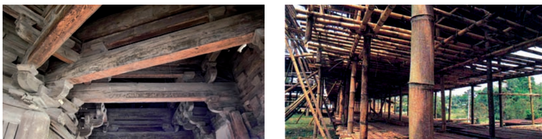
Fig.84: Types d'ossature : a) stabilité par poids propre, temple Foguang, Chine (source: http://humanscribbles.blogspot.ch ) ; b) stabilité par liaison, ossature en bambou, Indonésie (source: LANGLAIS, 2002)
