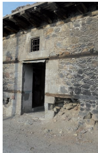
maintien en cas d'effondrement / les chaînages horizontaux empêchent l'écroulement de la partie supérieure en maçonnerie, évitant ainsi un effondrement complet du mur et facilitant la réparation de la partie endommagée
