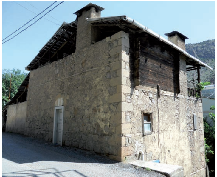
mur trumeau avec chaînage horizontal en bois
