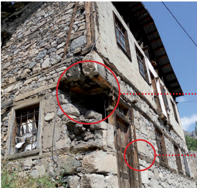
connexion traverse-poutre de chaînage
