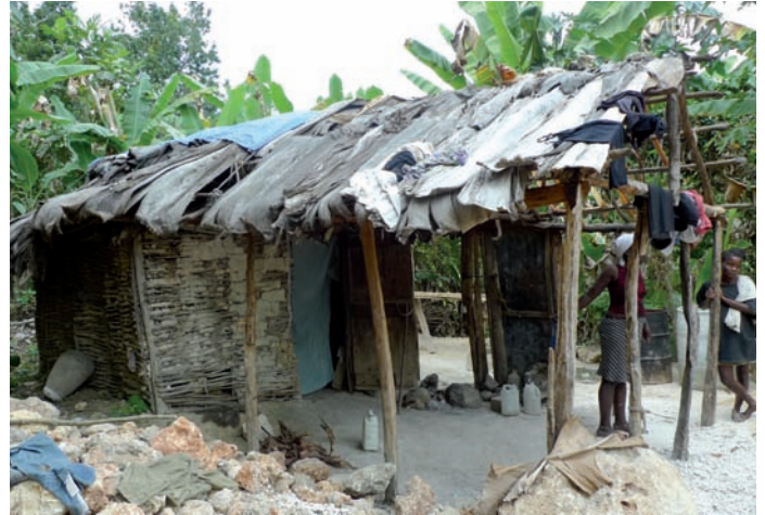
Angibeau : maison avec structure en bois et remplissage en panneaux clissés avec enduit en terre et badigeon à la chaux
