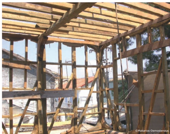
Ossature en bois à l'étage
