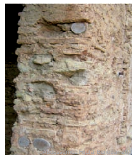
Détail du plancher: superposition des solives ©Abdessemed Foufa-Benouar 2008
