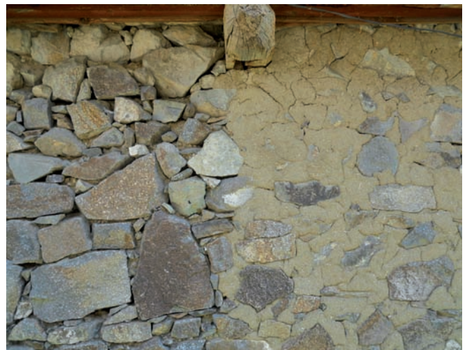
maçonnerie en pierre avec rejointement en mortier en terre fibrée
