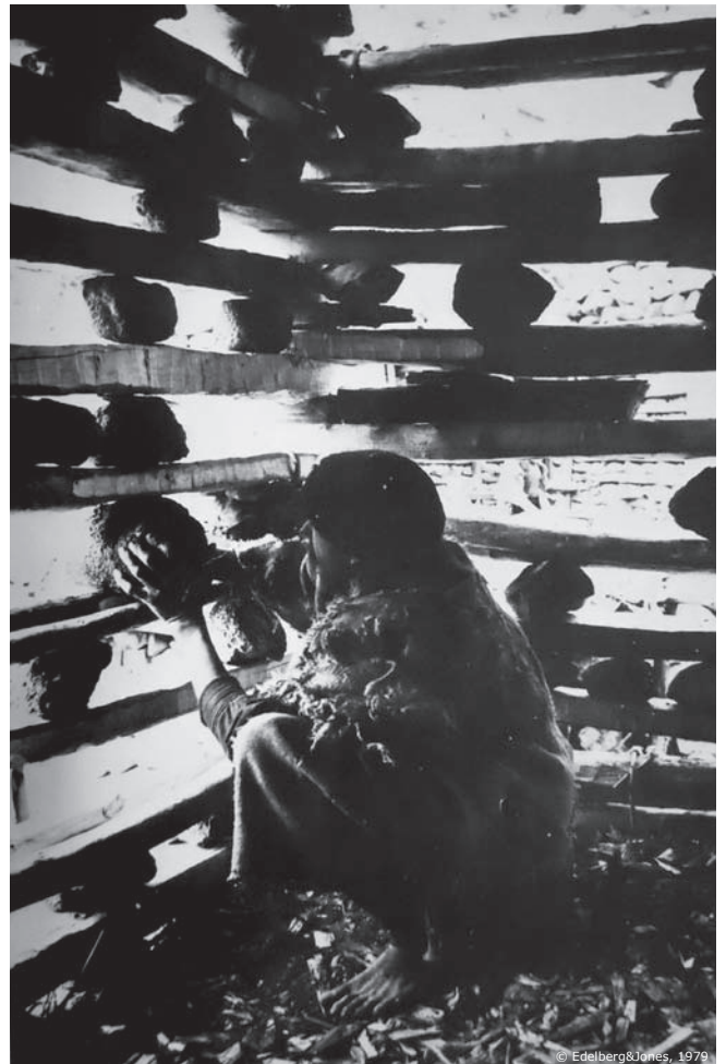
© Edelberg&Jones, 1979 Stabilisation temporaire des poutres part l'insertion de grosses pierres
