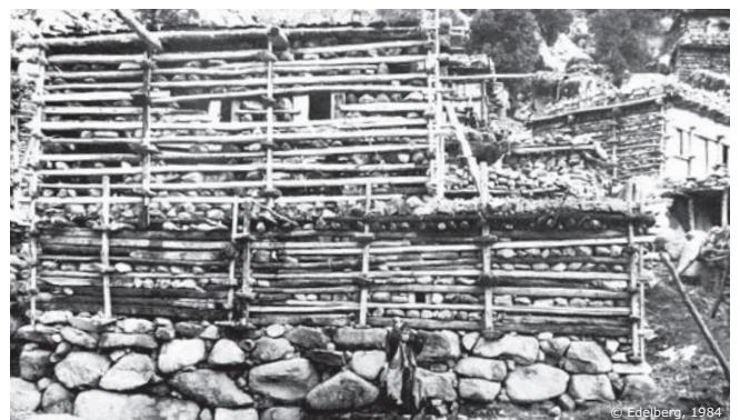
© Edelberg, 1984 Habitation en construction : le remplissage dans la partie supérieure n'a pas encore été complété
