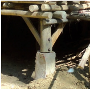
Fig.11: Région de Chittagong, adaptation à la typologie constructive (crédits: O. Moles) : a) habitation sur plateforme, contreventement de la structure portante ; b) habitation sur soubassement, masse d'usure
