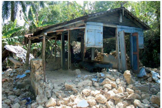
Séisme de 2010 : endommagement d'une kay tiwoch
