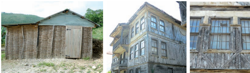
Fig.98: a) remplissage en panneaux ( kay klissage , Haïti) ; b et c) dizeme , remplissage en rondins (Bartın, Turquie)
