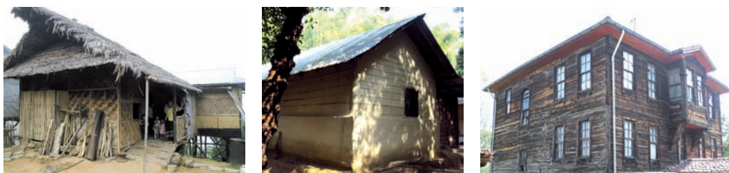
Fig.96: Structure avec parement en zone sismique : a) bambous tressés avec structure en bambou (Nagaland, Inde) ; b) panneaux végétaux avec enduit (Bangladesh) ; b) bardage en planches (Bartın, Turquie)
