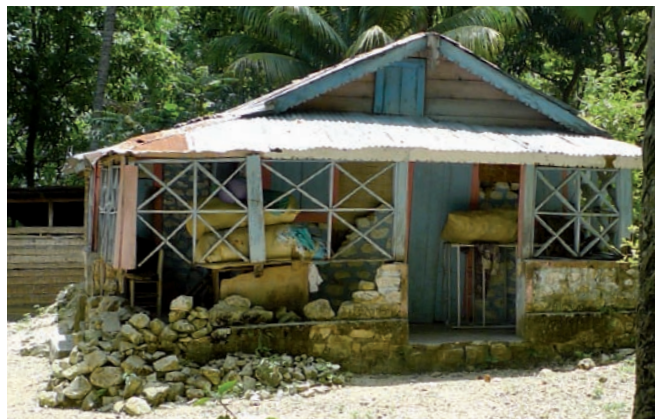
Séisme de 2010 : endommagement d'une kay tiwoch
