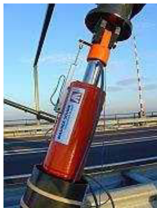
Figure 1.4. Suspension magnétorhéologique installée sur un pont [Harari et al., 2009]
