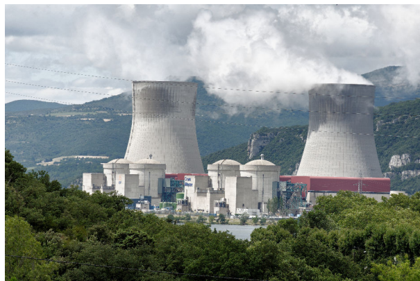
FIGURE 1: Photo de la centrale de Cruas-Meysse.
