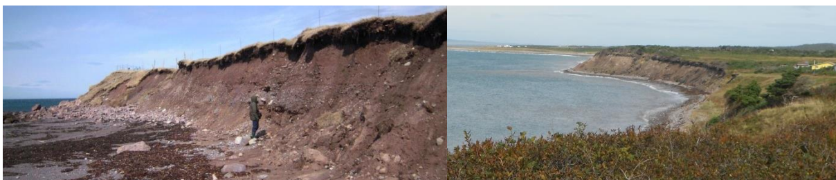
Figure II-5 : Photographies de front de moraines en érosion sur les côtes des îles de Miquelon (à gauche) et Langlade (à droite).
