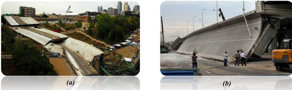
Figure 1.2: (a)- Image après l'effondrement d'un pont à Minneapolis en 2007 (b)-Effondrement d'un pont au nord-est de la Chine dans la ville de Harbin en 2011
