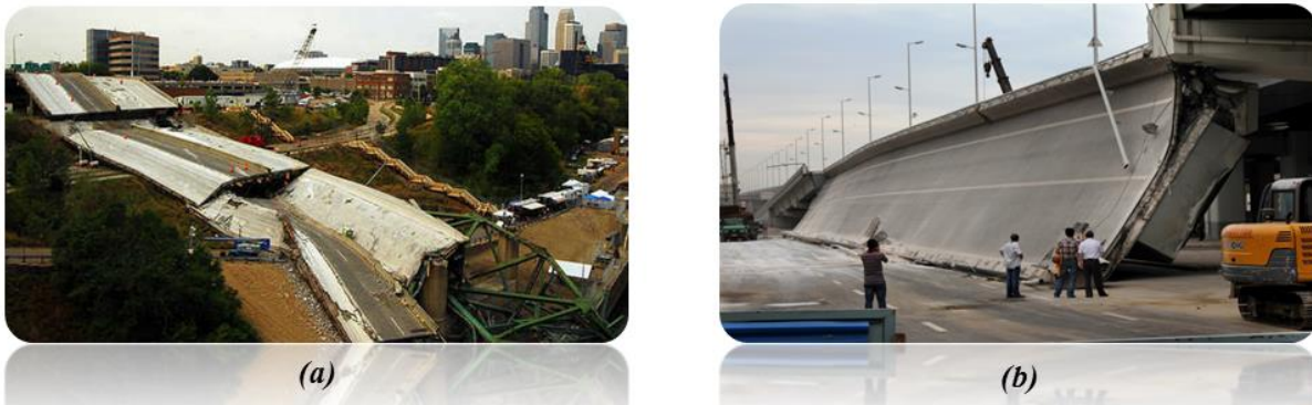
Figure 1.2: (a)- Image après l'effondrement d'un pont à Minneapolis en 2007 (b)-Effondrement d'un pont au nord-est de la Chine dans la ville de Harbin en 2011
