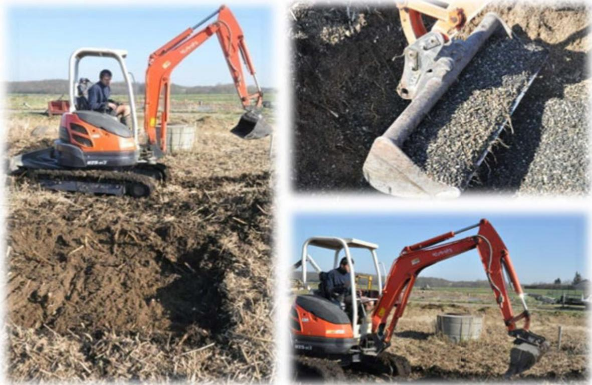
**[Figure II.20] Mini-pelle utilisée pour les prélèvements des boues et des matériaux filtrants du site Vercia.**
