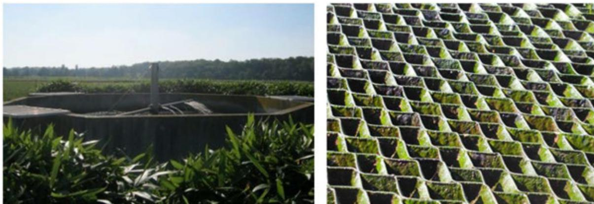
**[Figure II.18] Lit bactérien de la station de Vercia (à gauche) et développement du biofilm sur le garnissage du lit bactérien (à droite) (Rousset, 2009).**
