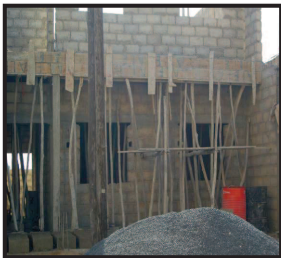
Photo 11 : Echafaudage en bois à Dakar (zone de captage)
