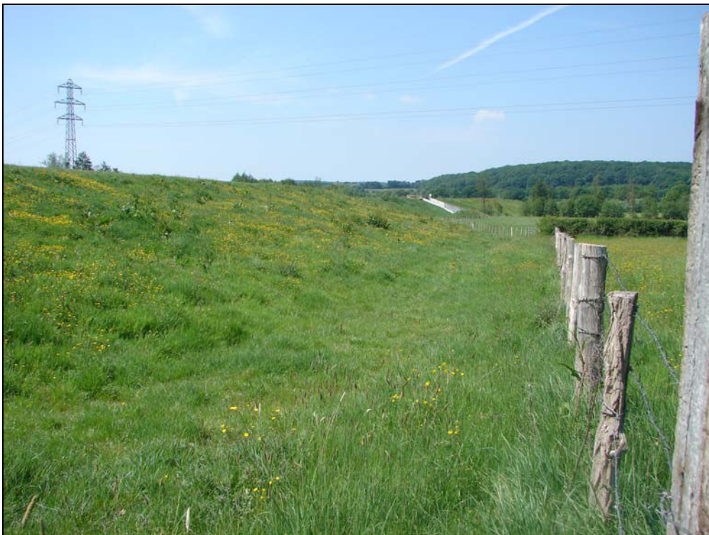
Figure 28 - La retenue de Margon : digue végétalisée (Cliché, A. Pancher).
