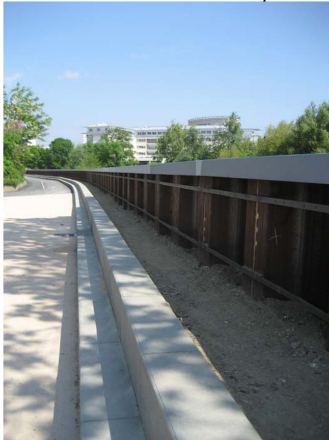
Figure 22 – Palplanches mises en place dans le quartier Australie-Heuzé.
