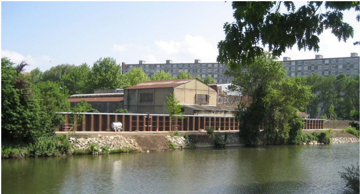
Figure 21 - Vue des travaux en voie de finalisation dans le quartier Australie-Heuzé.
