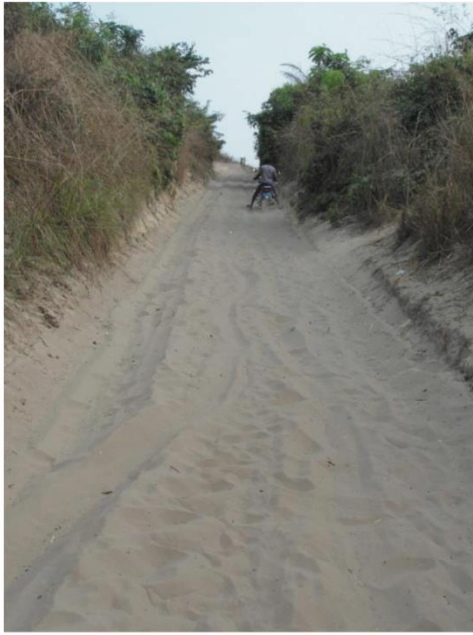
Rue à accessibilité médiocre dans le quartier Ndombe (Selembao)
