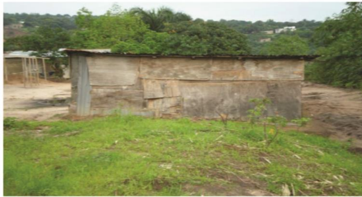
Une baraque à la périphérie du quartier Ngomba Kinkusa
