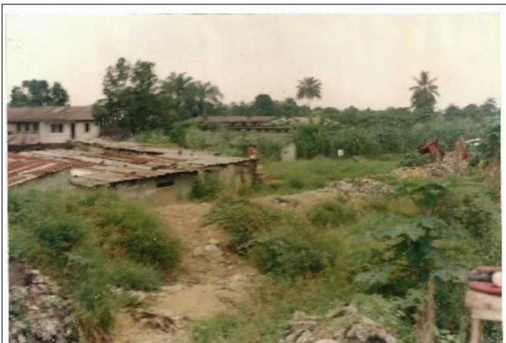
Ensablement des maisons dans le quartier Batende Matete
