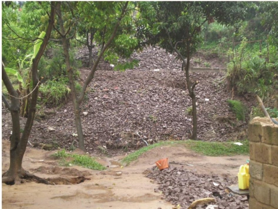
Caillasse obtenue de la destruction d'un collecteur d'eau à la cité La Colline
