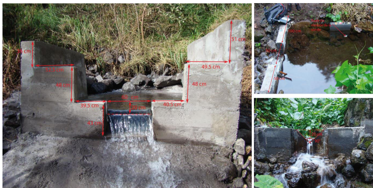
Figure 2.3 : Exemples de stations hydrométriques à section contrôlée du secteur de Grand Ilet. À gauche la station de la source Clain, à droite la station de la source Bélier.
