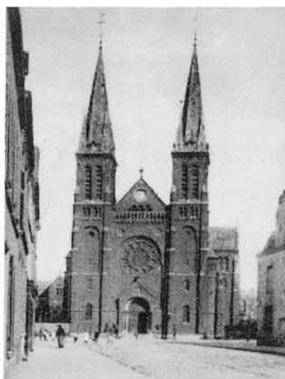
Figure 56 : l'église de Dunkerque : un archétype de l'église pour l'ensemble du panel
